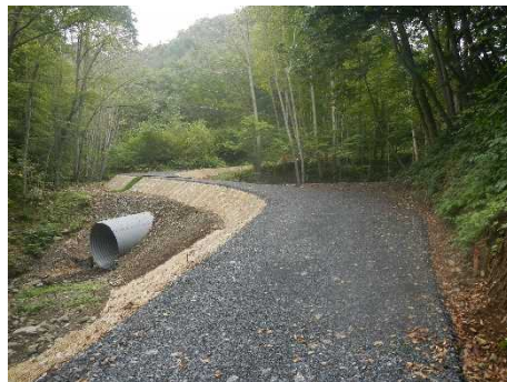
林道（林業専用道）新設
