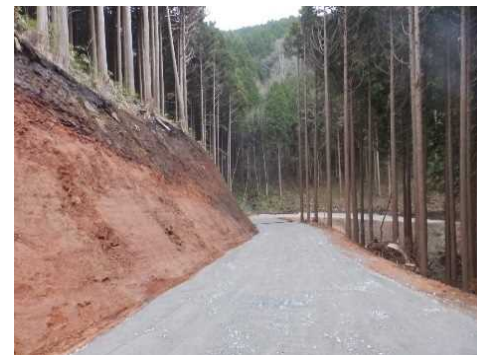
岐阜森林管理署 ミススリ林道 新設工事
