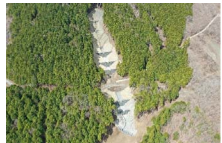
⑤ 角取山工区復旧状況(近景)
