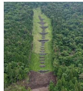
⑧ 立山工区復旧状況(遠景)
