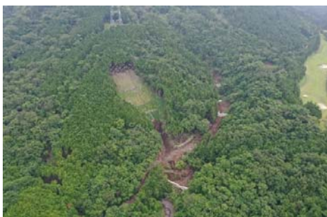
⑥ 奥の沢川工区荒廃及び復旧状況(遠景)
