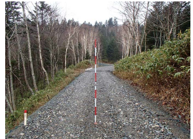
西の沢林道アイマベツ線 新設工事
