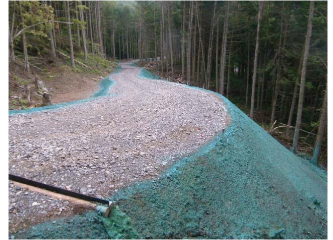
ヤルカラウシ林道 新設工事
