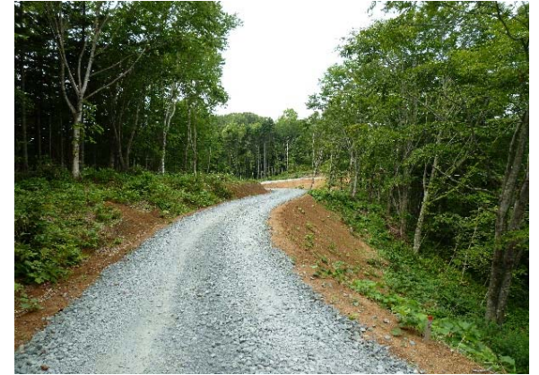
栄浜林道女男の沢支線 新設工事
