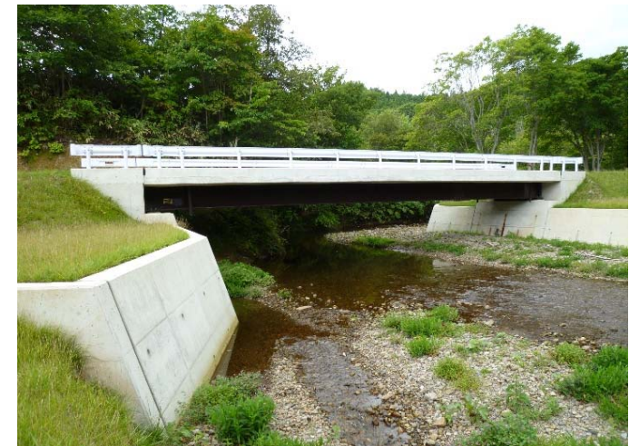
中の沢林道 改良工事
