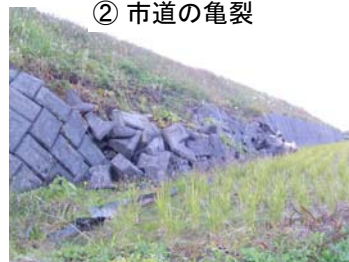
④ 市道下のブロック積擁壁の被災状況
