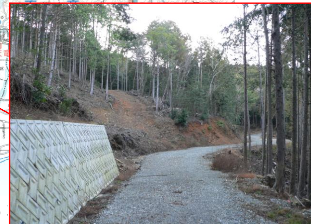
路網整備(林道の開設)
