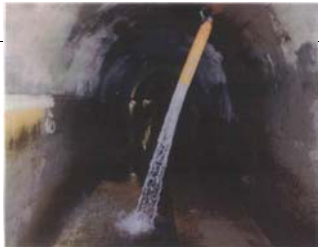
④排水トンネル工内(ボーリング暗きよ)
