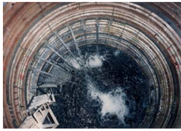
②集水井工
