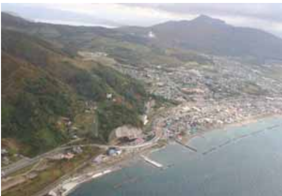
保全対象全景
