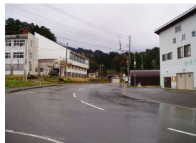
② 須川工区保全対象(県道403号)
