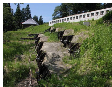
⑦ 伏野工区復旧状況
