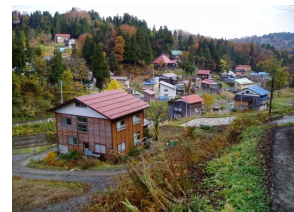
③ 音沢工区保全対象(天水越集落)
