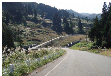
⑤ 音沢工区復旧状況
