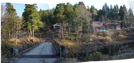
① 伏野工区保全対象(伏野集落及び河川)
