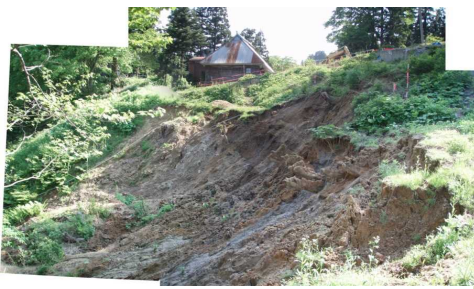
⑥ 伏野工区着手前(被害状況)
