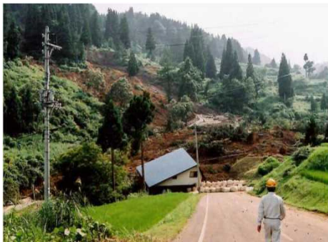
④ 音沢工区着手前(被害状況)
