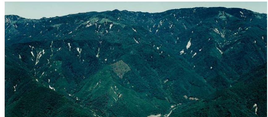
荒廃状況(全景)
