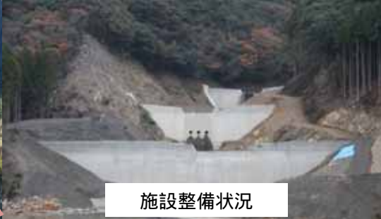
対策工追加箇所の例 (十津川村野尻)
