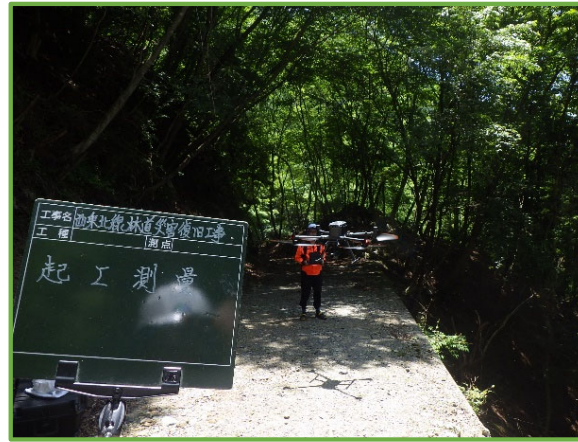
3次元起工測量
