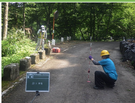
3次元起工測量の様子
