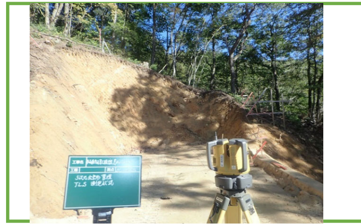
地上型レーザースキャナーによる出来形計測状況
