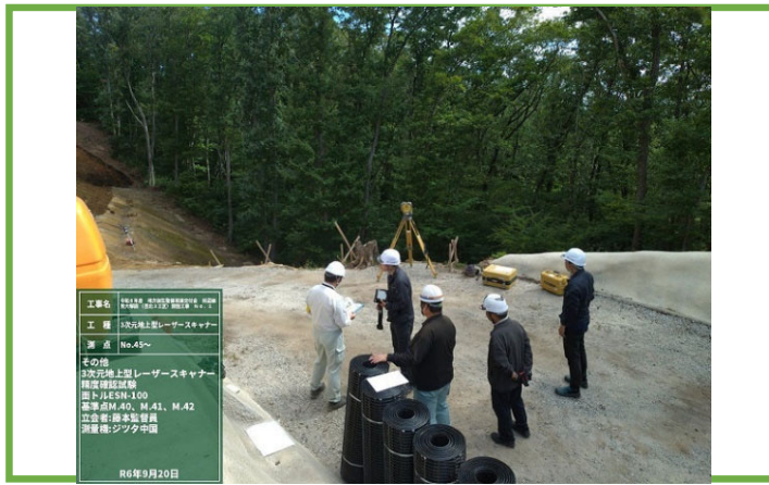
3次元地上型レーザースキャナー 精度確認試験
