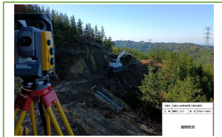
自動追尾型トータルステーションを使用したICTマシンコントロール施工を実施
