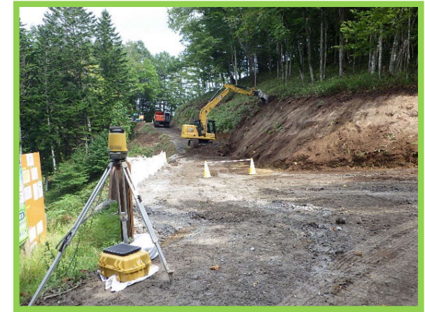
MCバックホウによる切土工施工
