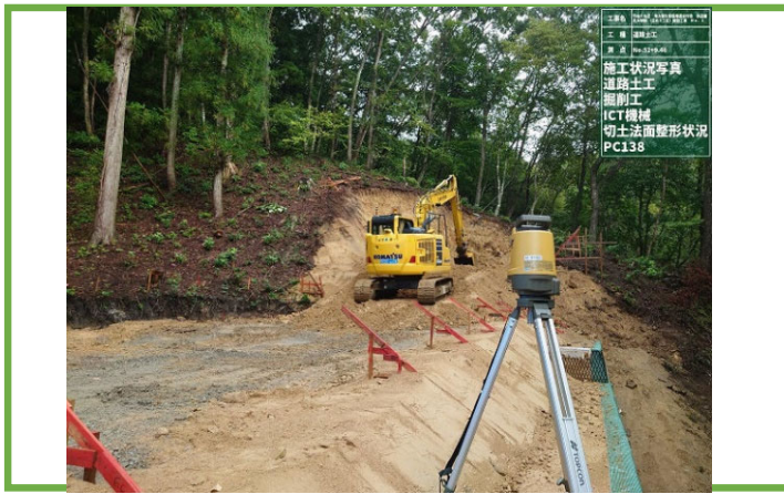
ICT機械による切土法面整形状況
