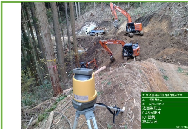
MG付きバックホーによる掘削(法面整形)
