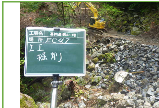
MGバックホウによる掘削状況
