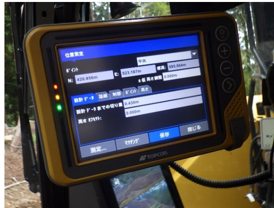
ICT建機施工
