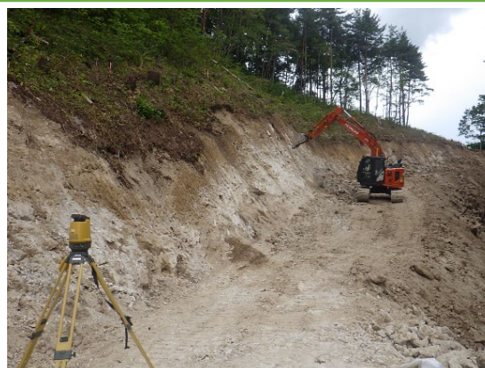
MGバックホウによる法面整形
