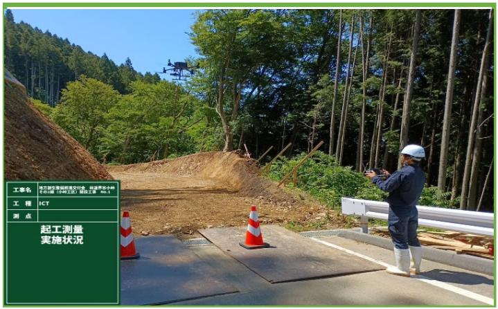
3次元起工測量
