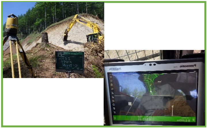
ICT建設機械の稼働状況
