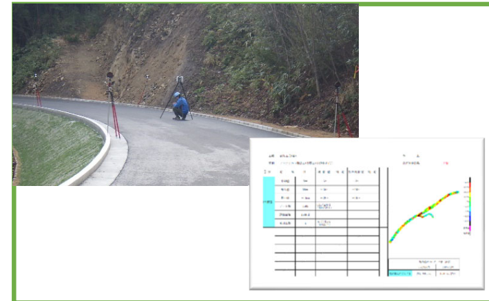
地上レーザースキャナーによる出来形計測 出来形ヒートマップ
