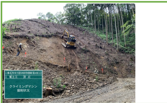
無人掘削機による土工
