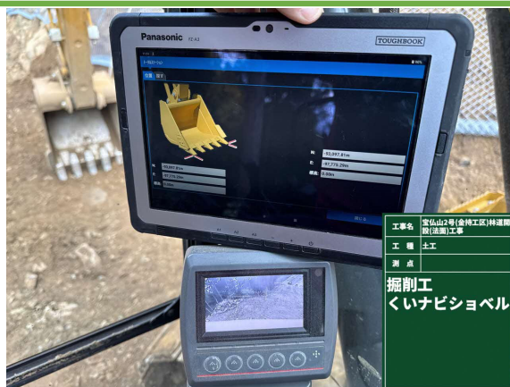
タブレットで計画断面とシヨベル先端の位置関係を把握
