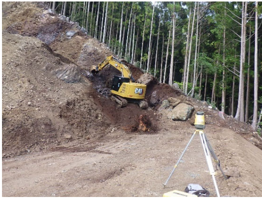
ICT建機施工
