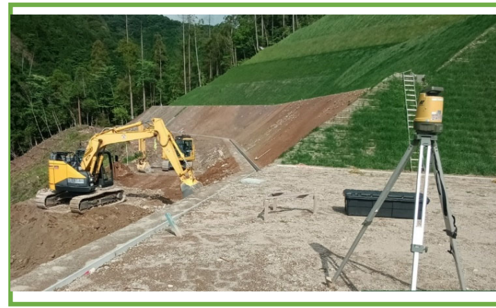
MGバックホウによる掘削・切土法面整形
