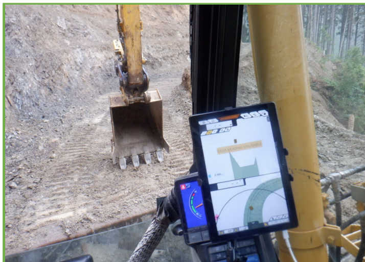
MGバックホウによる掘削
