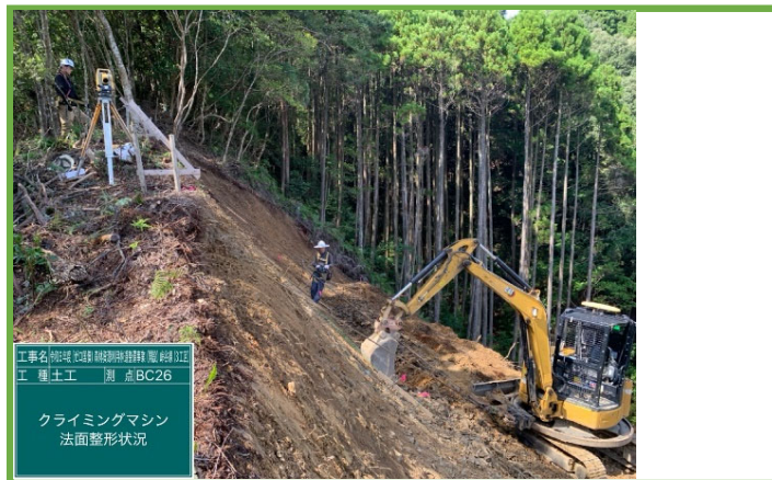
無人掘削機による法面整形
