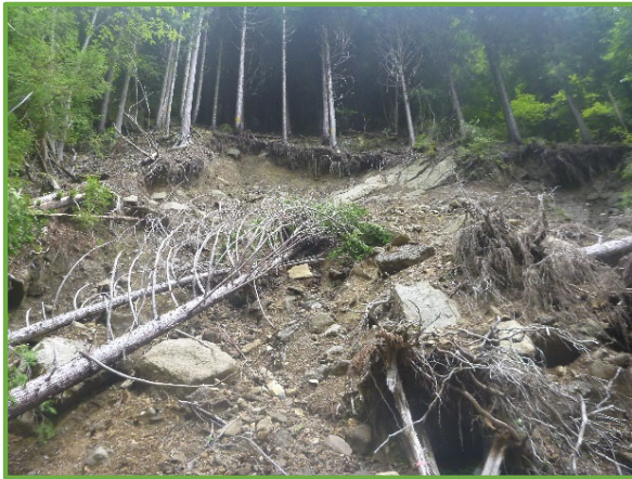
工事着手前の現地状況
