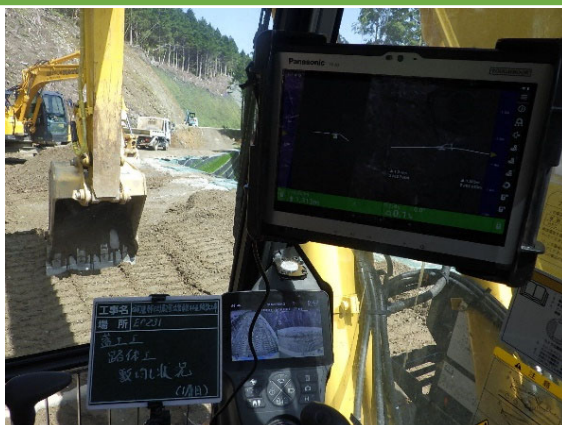
盛土敷均し層高さ確認状況
