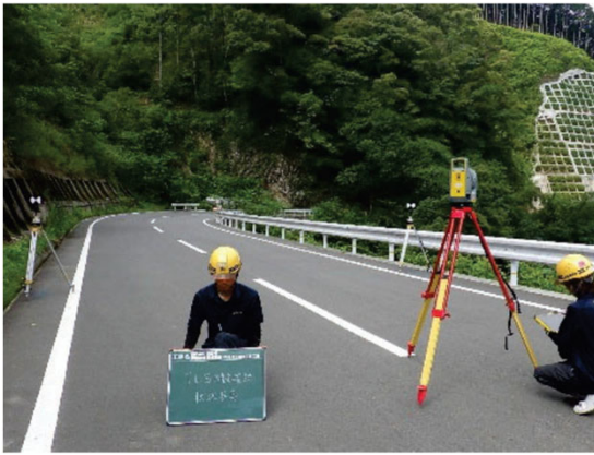
レーザースキャナー起工測量状況
