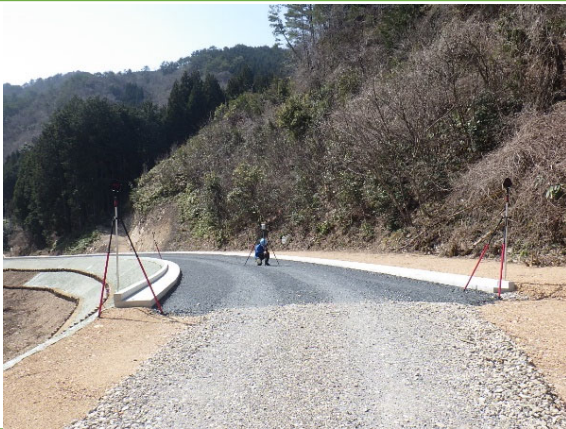
3次元起工測量（地上レーザースキャナー）
