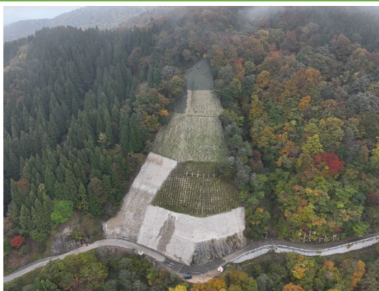
施工箇所全景
