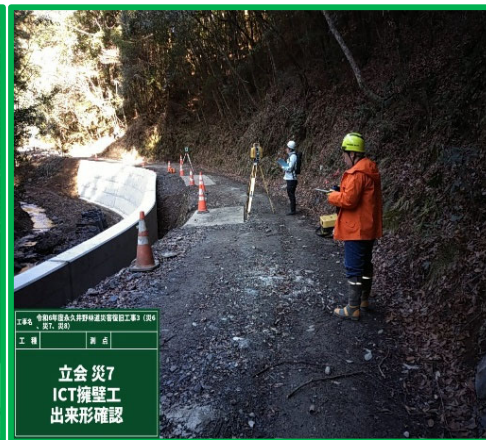
地上型レーザースキャナによる出来形立会・確認
