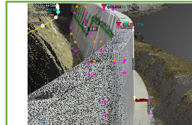
点群出来形計測状況
