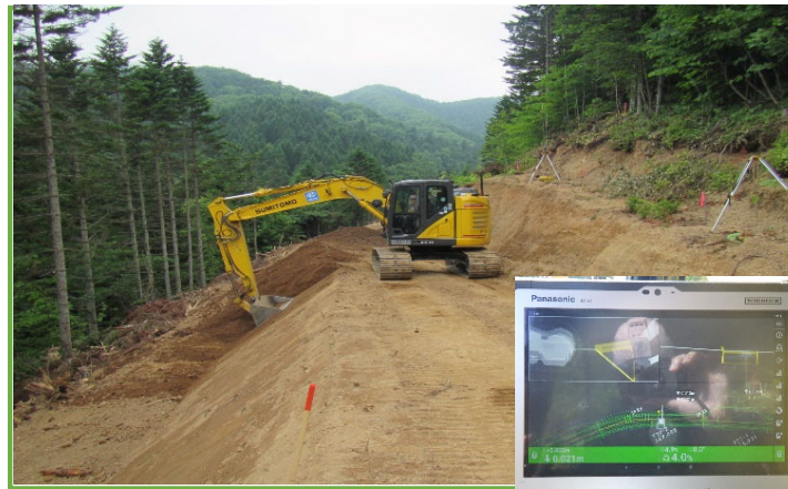
MGによる法面整形状況
