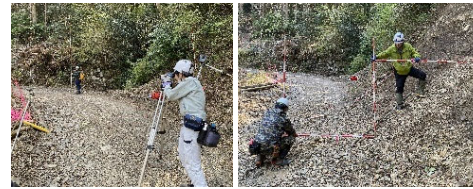
自動レベルによる縦断(左)とポール横断(右)
