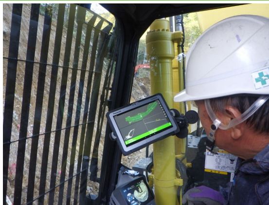
3D-MGバックホウによる掘削作業
