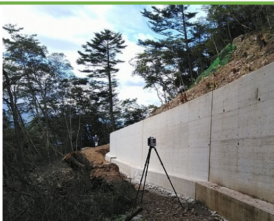
レーザースキャナー測量状況
