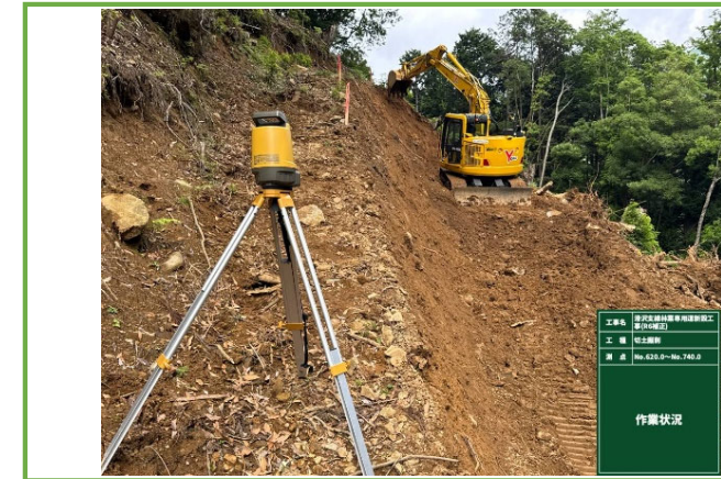
杭ナビLN-150を活用した施工状況
