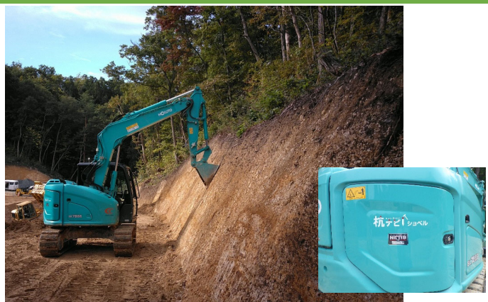
MGバックホウによる掘削・法面整形
