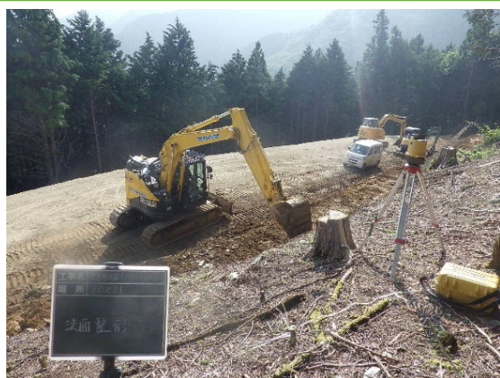
切土法面整形状況
