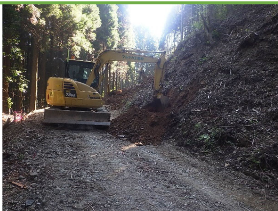
MGバックホウによる掘削
