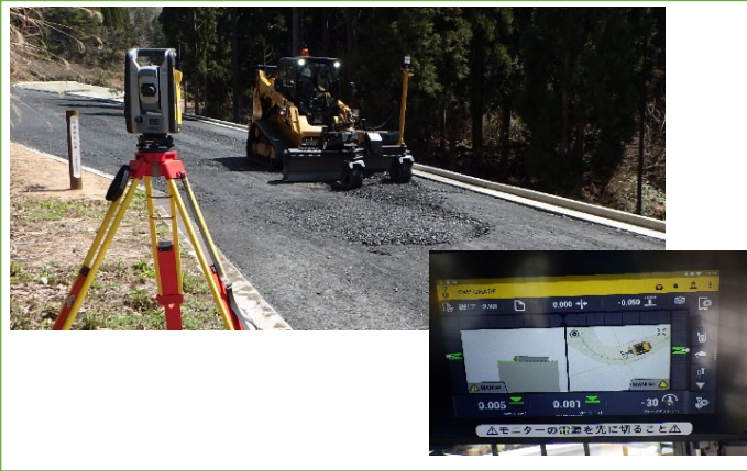
ICT建機による上層路盤工
