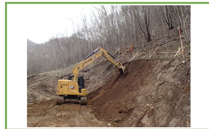
3D-MG LPS（杭ナビ）装着機による掘削状況
