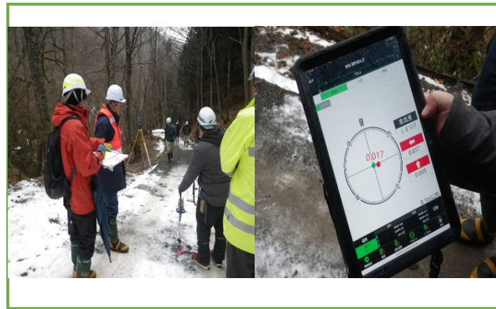
タブレット上で出来形確認
