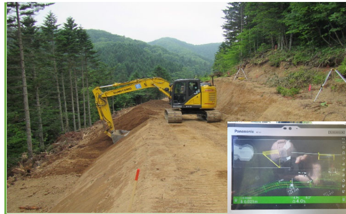
MGによる法面整形状況
