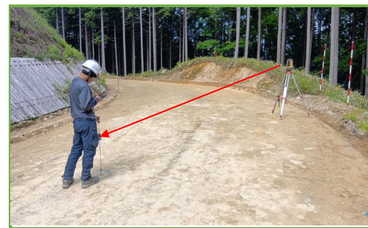
自動追尾測量機器(杭ナビ)の活用
