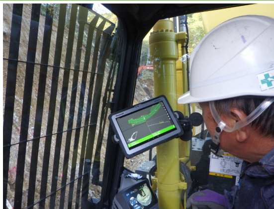
3D-MGバックホウによる掘削作業
