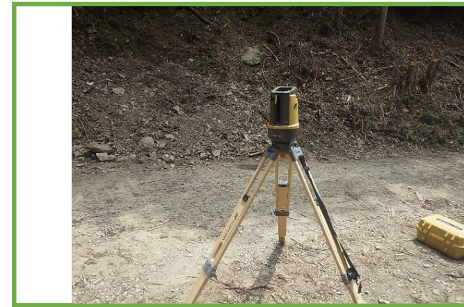
LN-150設置状況
