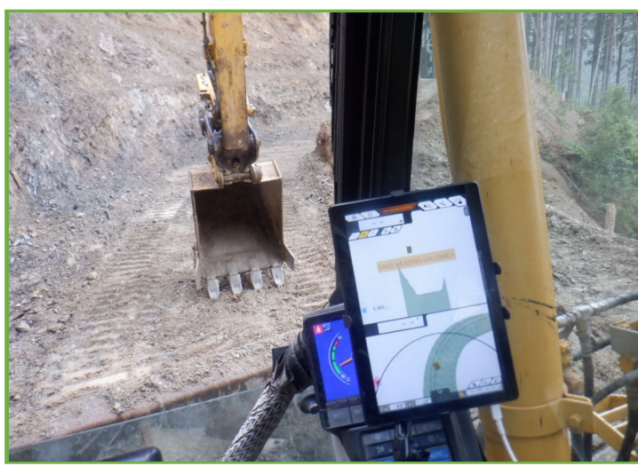
MGバックホウによる掘削
