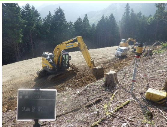
切土法面整形状況
