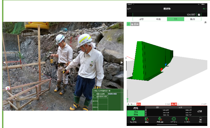
3次元モデルを使用した測量（タブレット上で3次元モデルと合わせて確認可能）
