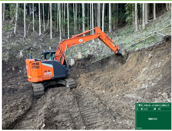
MCバックホウ掘削状況
