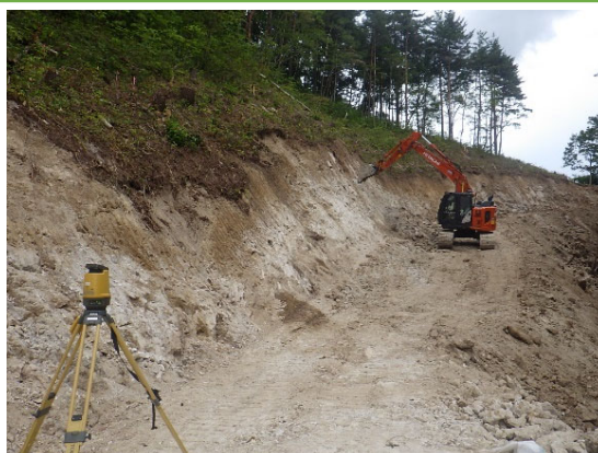
MGバックホウによる法面整形
