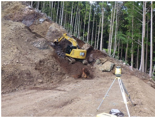
ICT建機施工
