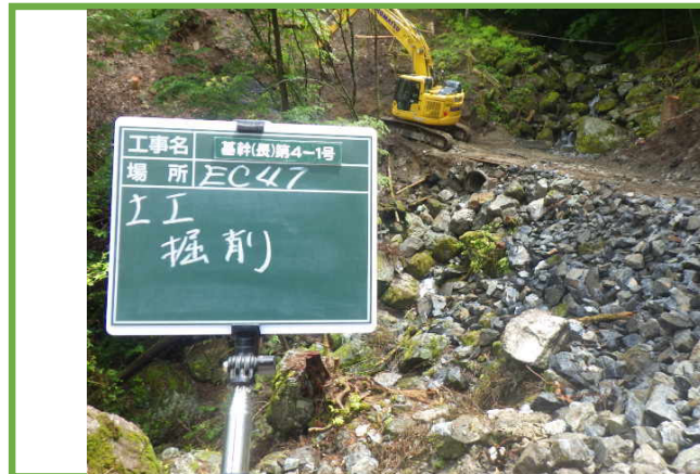
MGバックホウによる掘削状況
