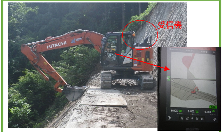
ICT対応バックホウ及びモニター
