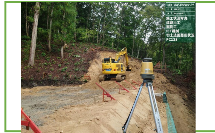
ICT機械による切土法面整形状況
