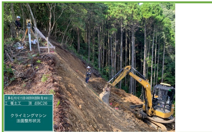
無人掘削機による法面整形
