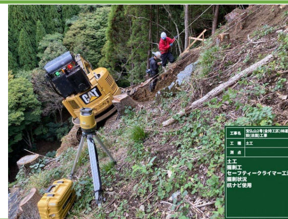
セーフティクライマー工法（杭ナビ使用）
