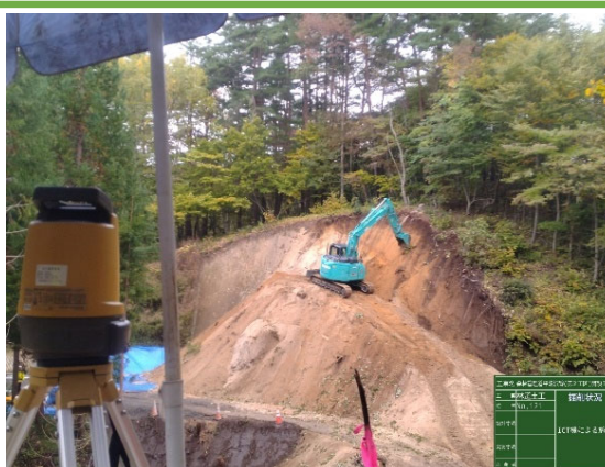
3D-MG LPS（杭ナビ）装着機による掘削状況
