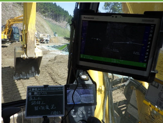
盛土敷均し層高さ確認状況
