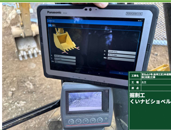
タブレットで計画断面とシヨベル先端の位置関係を把握
