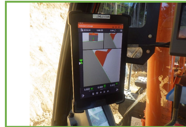
マシンガイダンス稼働状況
