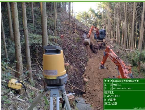
MG付きバックホーによる掘削(切土)
