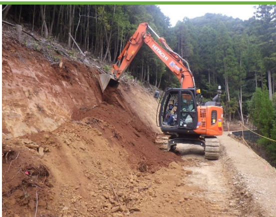
ICT建設機械施工による法面整形作業
