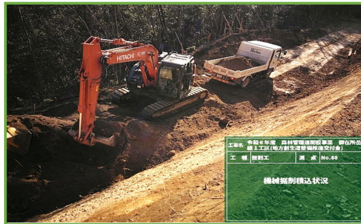
MC付きバックホウによる掘削
