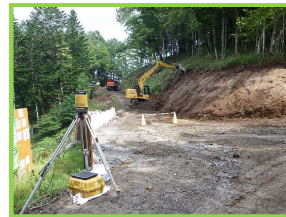
MCバックホウによる切土工施工
