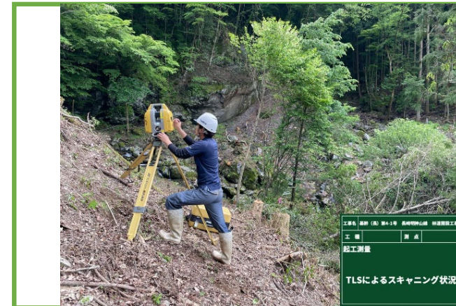
TSLによるスキャニング状況
