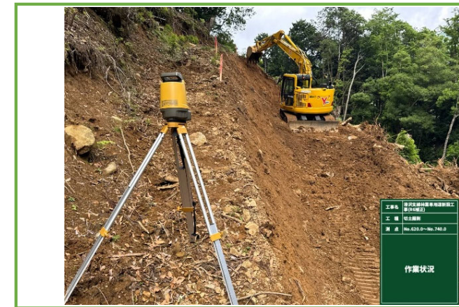
杭ナビLN-150を活用した施工状況
