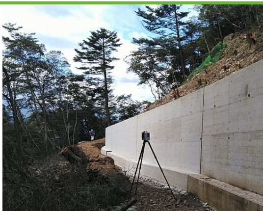
レーザースキャナー測量状況
