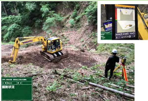
MGバックホウによる掘削
