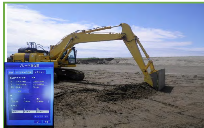
MCバックホウによる掘削
