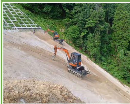
MG法面掘削機による掘削作業
