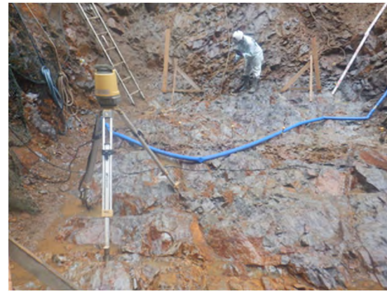
床付け出来形検測状況
