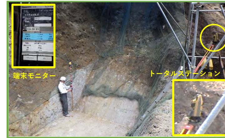
掘削工出来形計測
