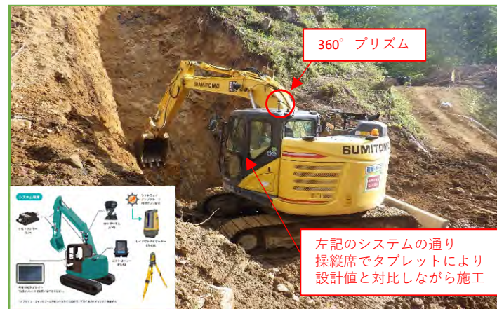
谷止工 掘削状況
