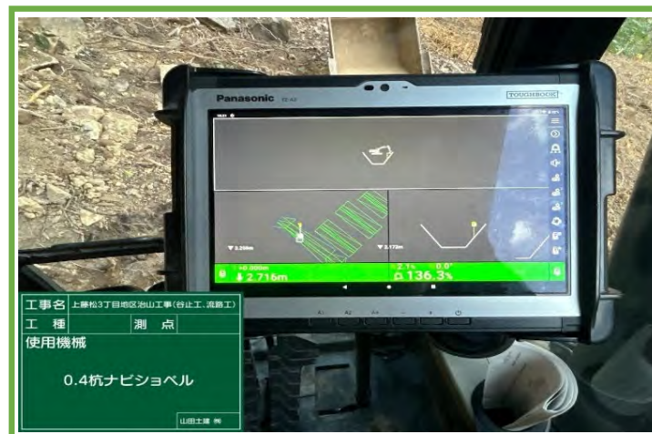
3次元データで高精度な掘削
