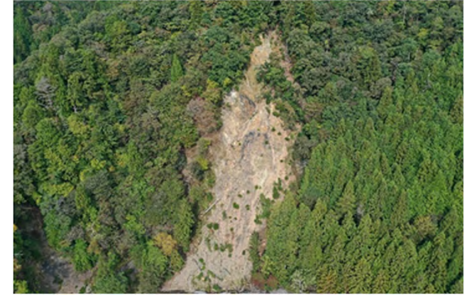
現地状況（空中写真）
