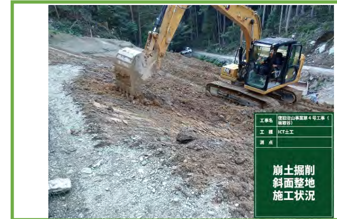
ICT土工 掘削・法面整形施工状況
