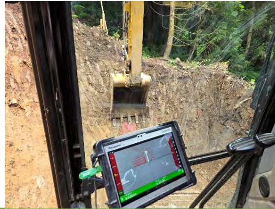
MGバックホウによる掘削
