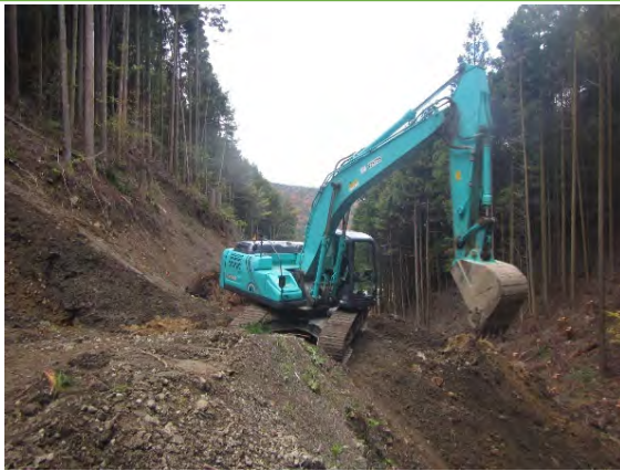
MGバックホウによる掘削
