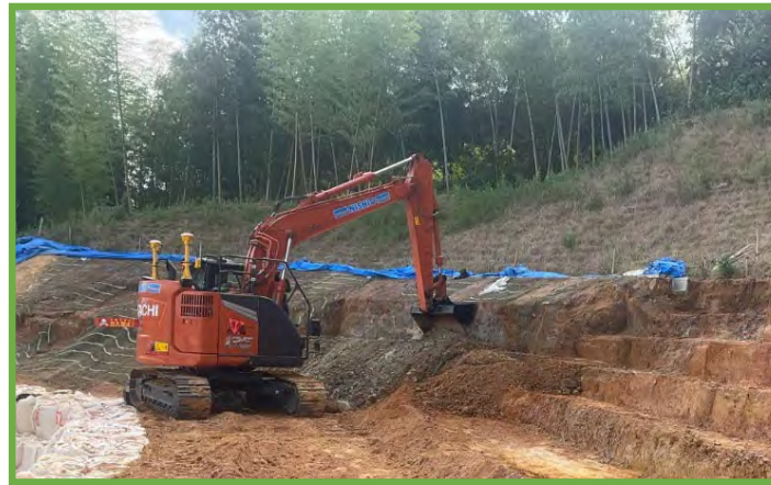
施工状況(MCバックホウによる段切り)
