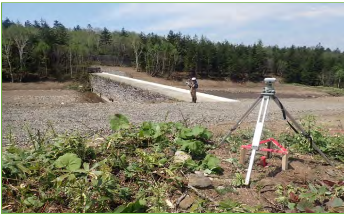
レーザースキャナによる起工測量（計測状況）
