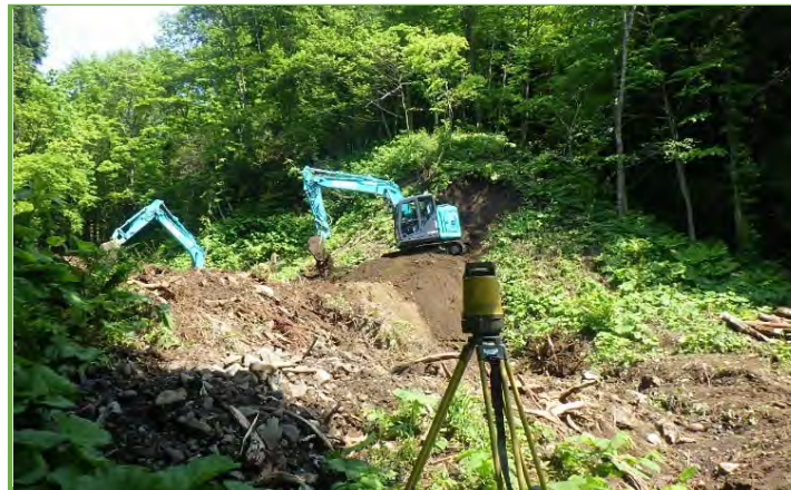
MGバックホウによる掘削作業
