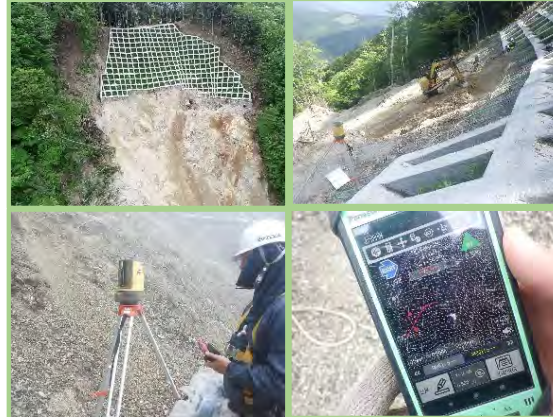
3次元設計データの活用による掘削作業
