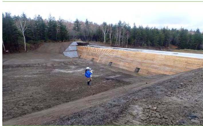
レーザースキャナによる出来形管理（計測状況）
