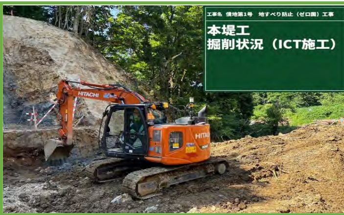
MGバックホウによる掘削作業
