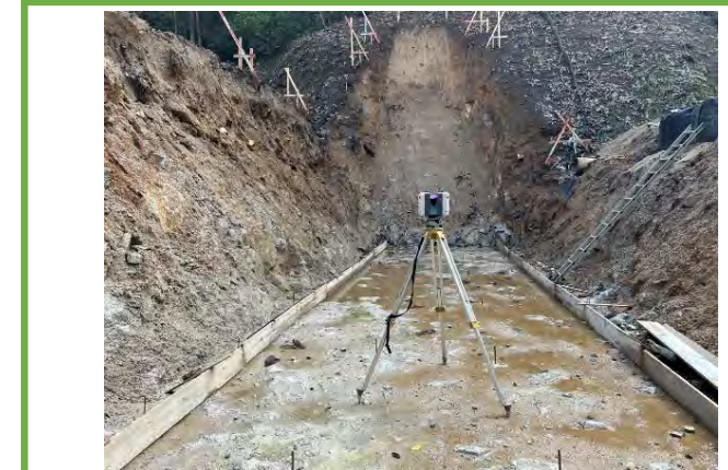
床掘出来形確認
