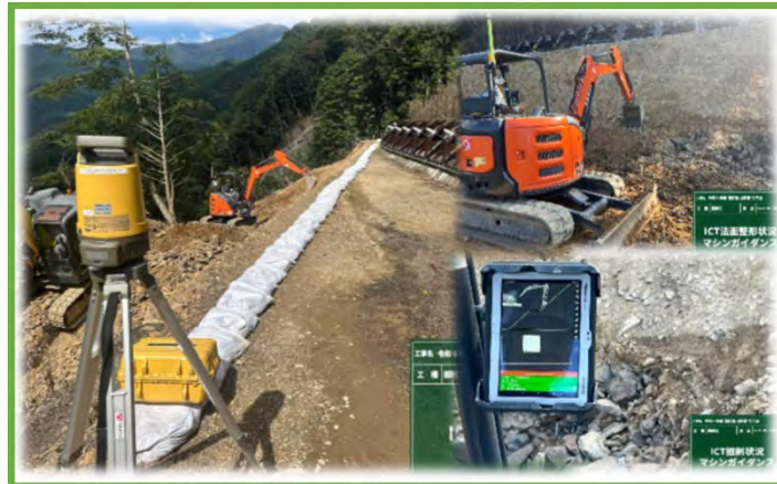
杭ナビショベルによるICT施工
