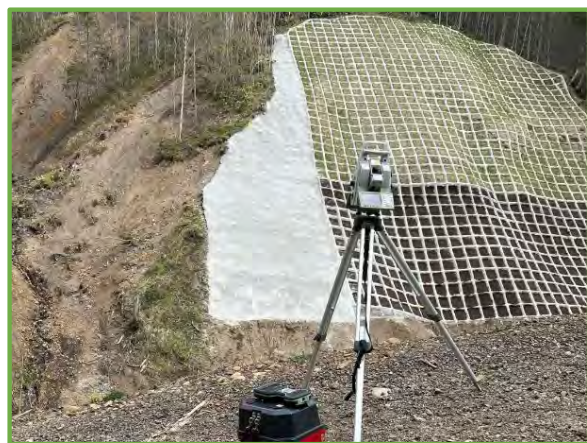
地上型レーザースキャナによる起工測量
