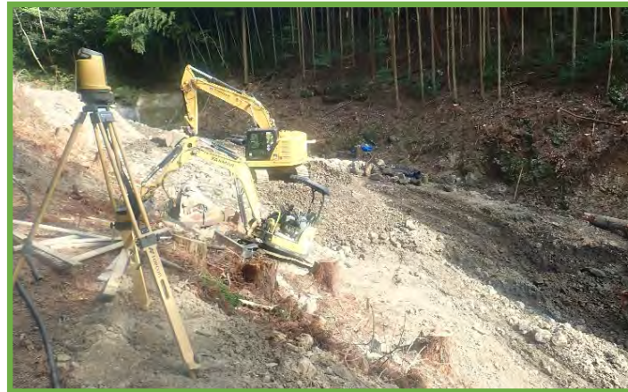
杭ナビ設置状況
