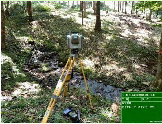
TLSによる起工測量
