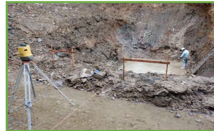
杭打ちナビによる測量状況
