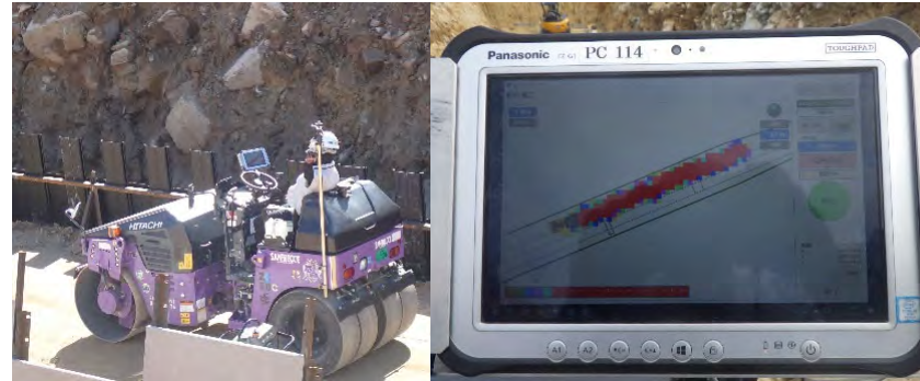
自動追尾型TSを用いた ICT建機による中詰材の締固め管理
