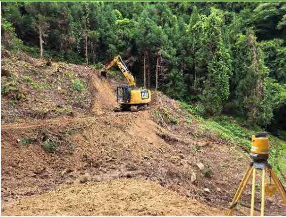
地上型レーザースキャナーによる 3次元起工測量
