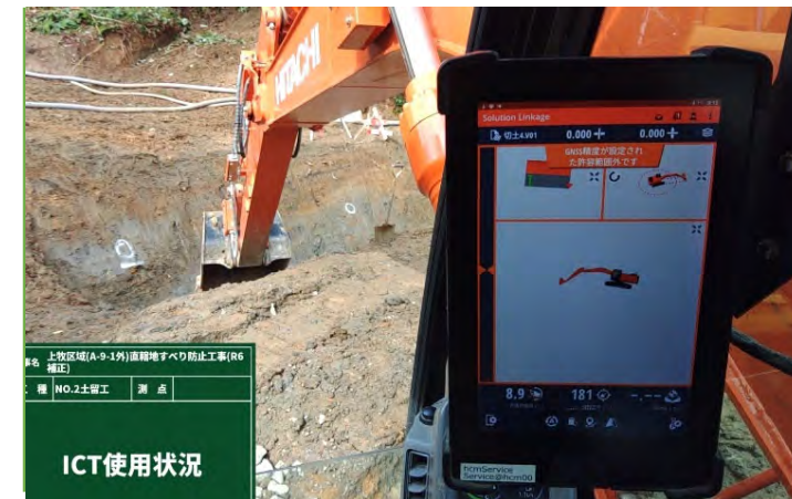
掘削状況 (ガイダンス)
