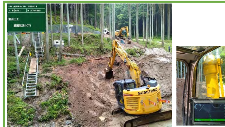
MGバックホウによる掘削 車内モニター(右)
