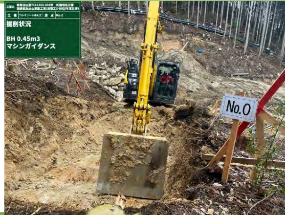
MGバックホウによる施工
