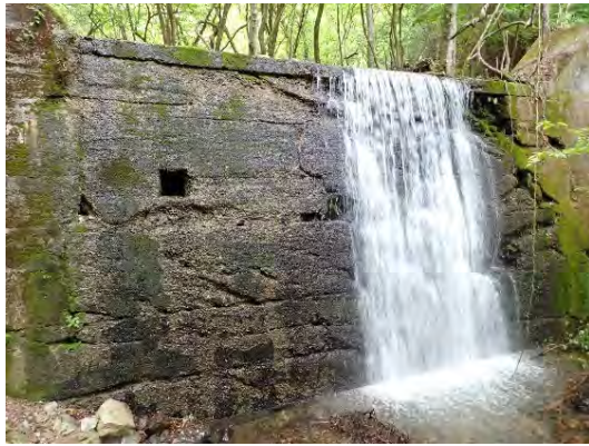
補修対象施設
