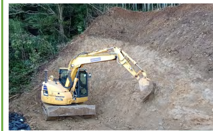
ICT法面整形状況
