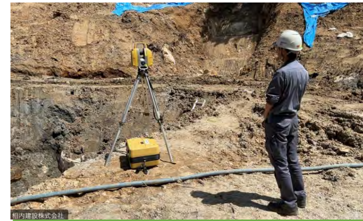
レーザースキャナによる出来形計測
