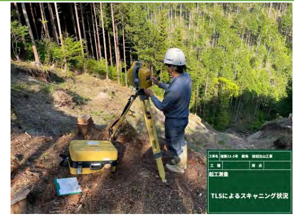
地上型レーザースキャナーによるスキャンニング状況
