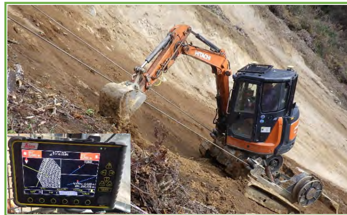
マシンガイダンスによる法面掘削
