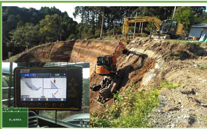
MGバックホウによる施工
