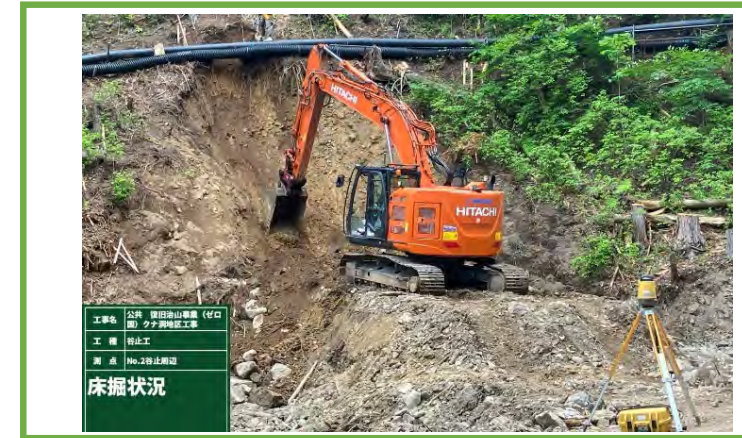
谷止工の掘削状況
