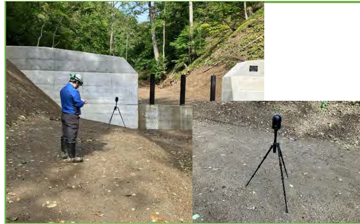
レーザースキャナーによる3次元出来形計測
