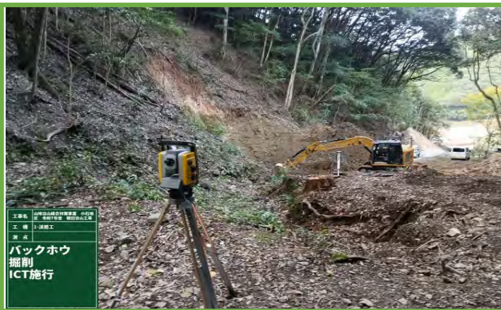
MCバックホウによる掘削作業
