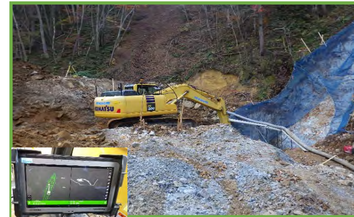
MGバックホウとタブレットによる掘削状況
