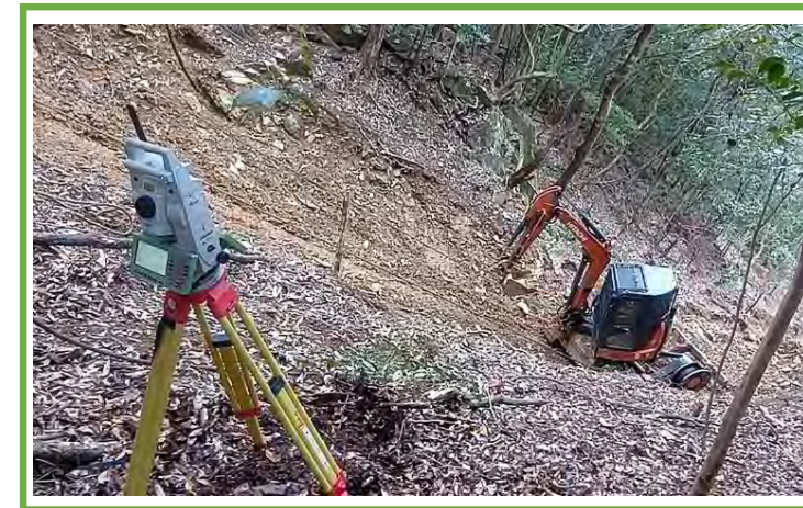
ICT掘削作業
