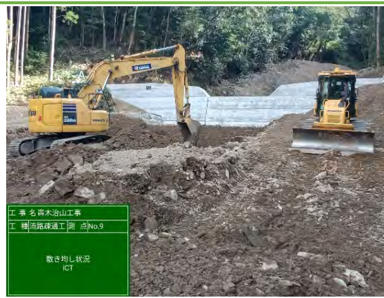
施工状況（盛土・法面整形）
