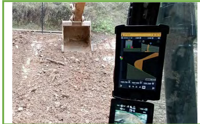
ICT土工施工時モニター
