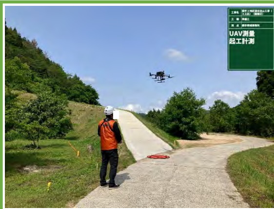
UAVによる3次元起工測量
