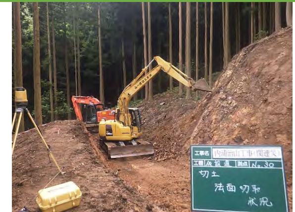
ICT建機施工
