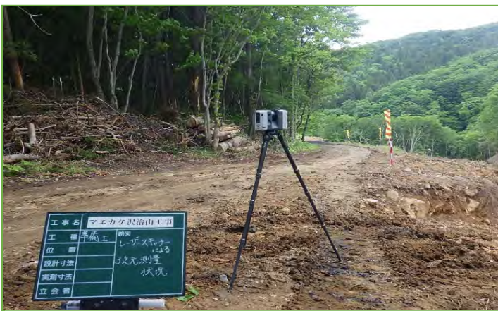
3次元起工測量実施状況
