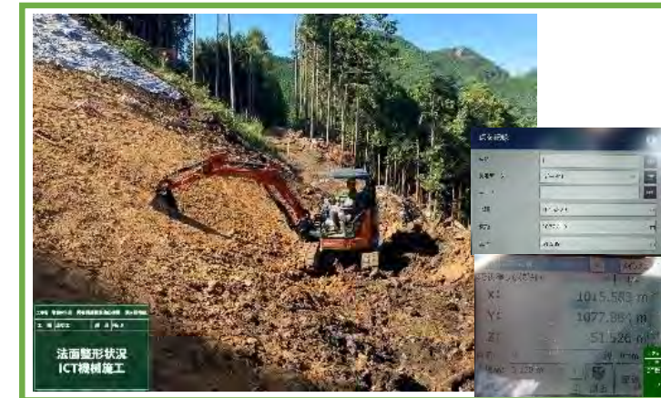
ICT (MG) バックホウによる法切
