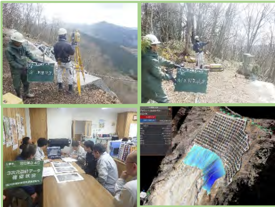
地上型レーザースキャナー及びUAVを使用した起工測量、3次元設計データの作成
