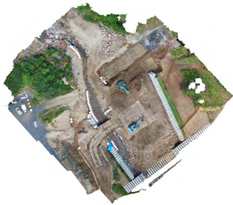
3次元データから作成したオルソ画像（床掘後）
