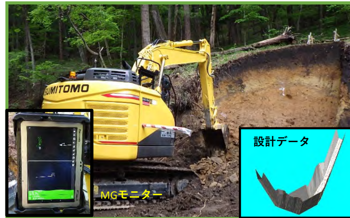
MGバックホウによる掘削
