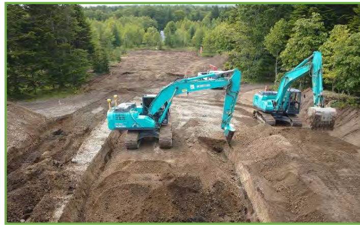
ICT建機 (MCバックホウ) 施工中
