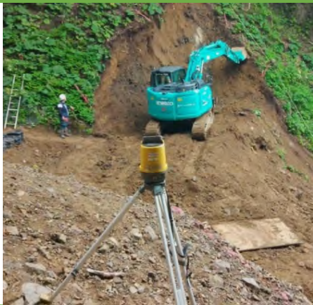
掘削作業状況
