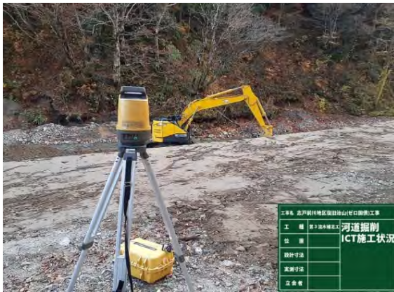
施工履歴 ICT施工状況（杭ナビシステム）
