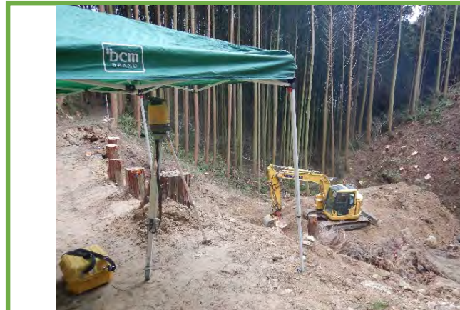
MGバックホウによる掘削
