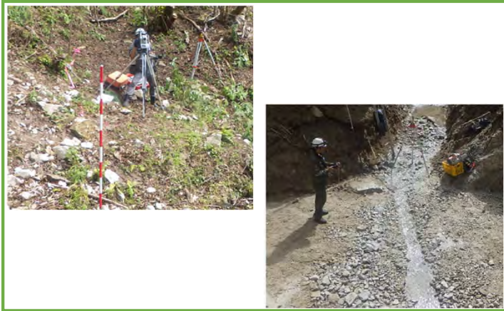
TLSによる測量
