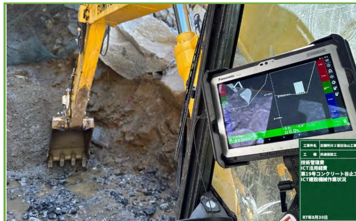
マシンガイダンスによる土工の施工状況
