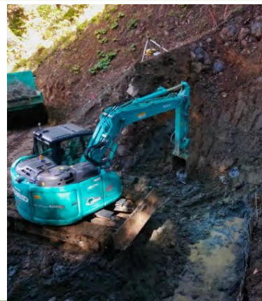
掘削作業状況
