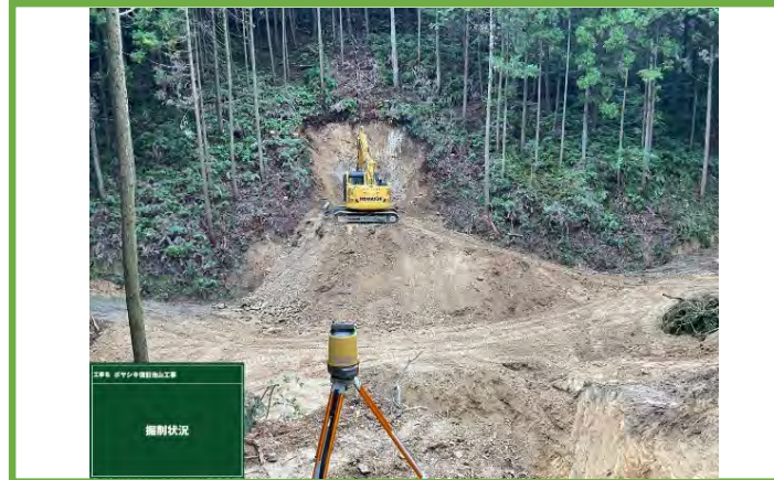
MGバックホウによる掘削
