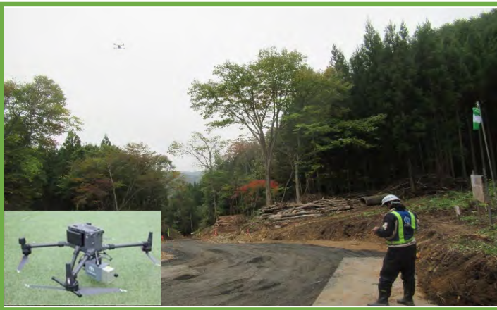
UAVによる起工測量状況
