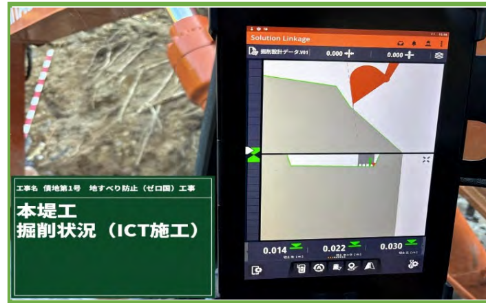
タブレット端末による掘削
