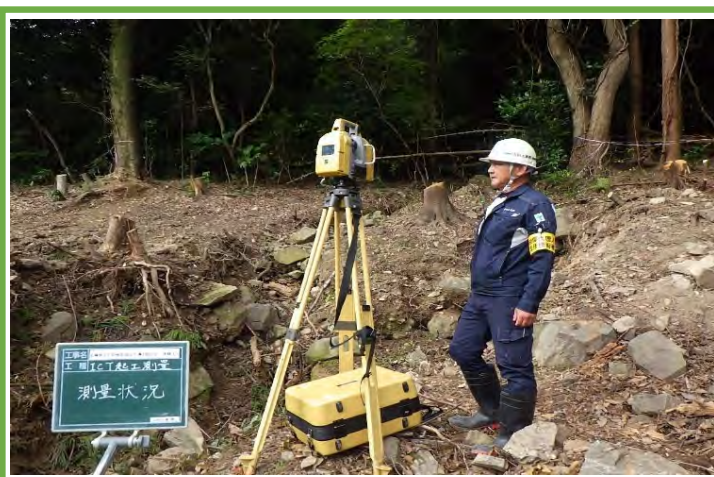
測量状況写真
