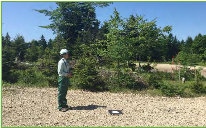
UAVによる起工測量
