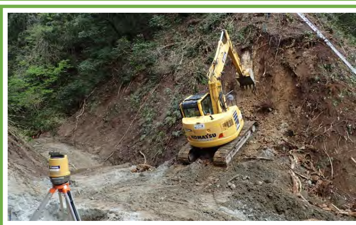
MGバックホウによる掘削作業
