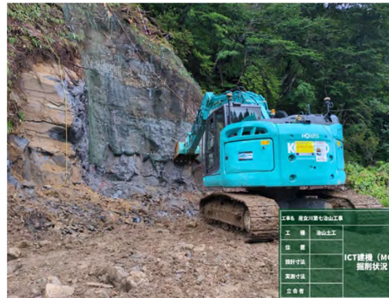
ICT建機による掘削状況
