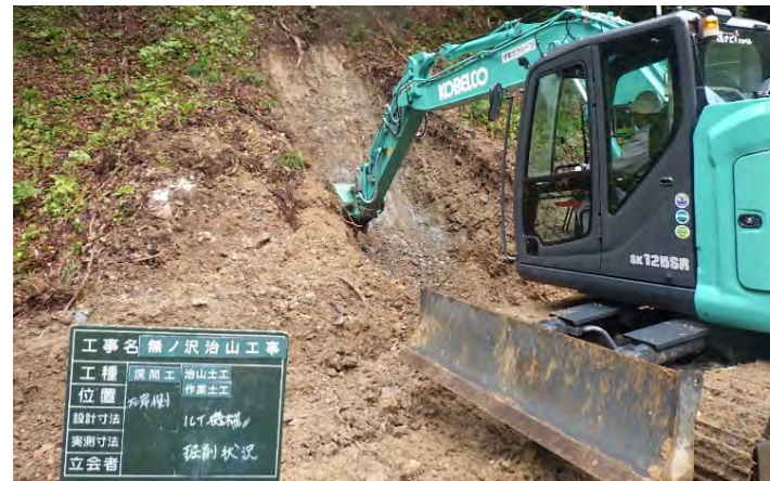
MGバックホウによる掘削作業
