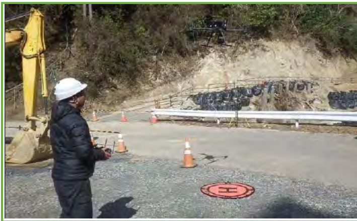
ドローンによる測量
