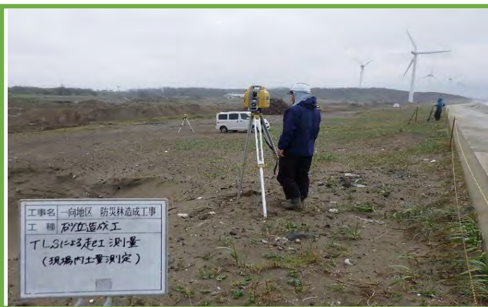
地上型レーザースキャナーによる起工測量
