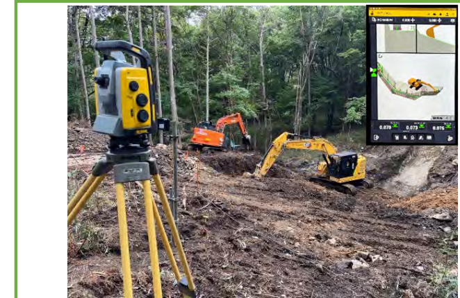
MG・MCバックホウによる掘削
