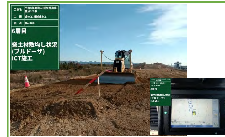
MCブルドーザーによる敷き均し
