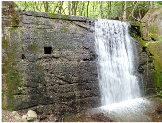
補修対象施設
