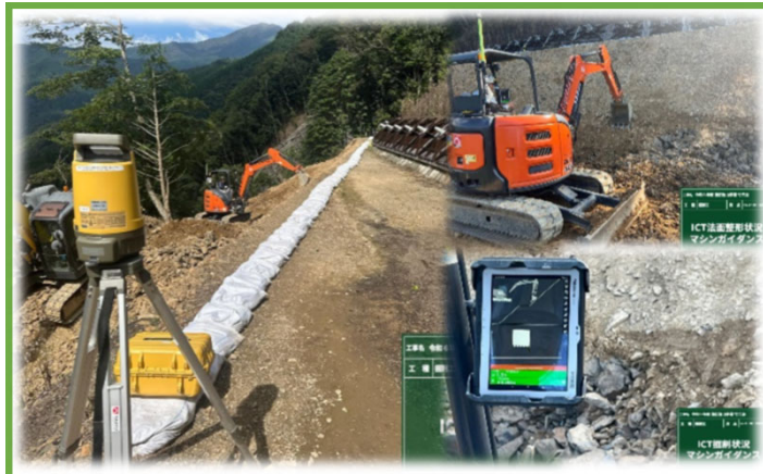
杭ナビショベルによるICT施工
