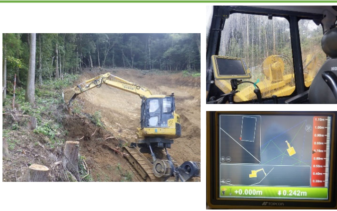
MGバックホウによる高所法面掘削
