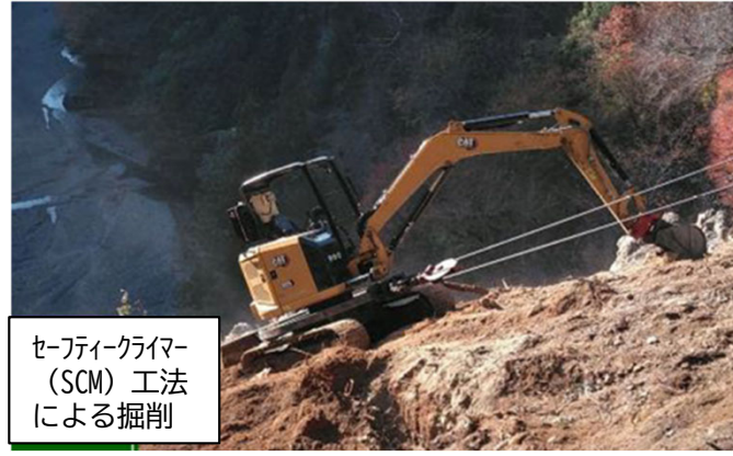
現地状況（高所無人掘削機が必要なほど急峻）
