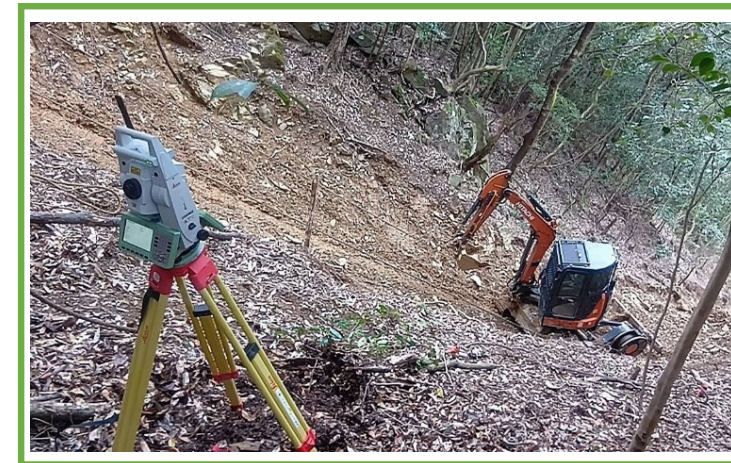
ICT掘削作業
