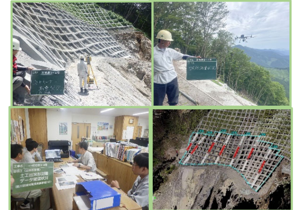
地上型レーザースキャナー及び、UAV測量による出来形管理、3次元データの納品・検査
