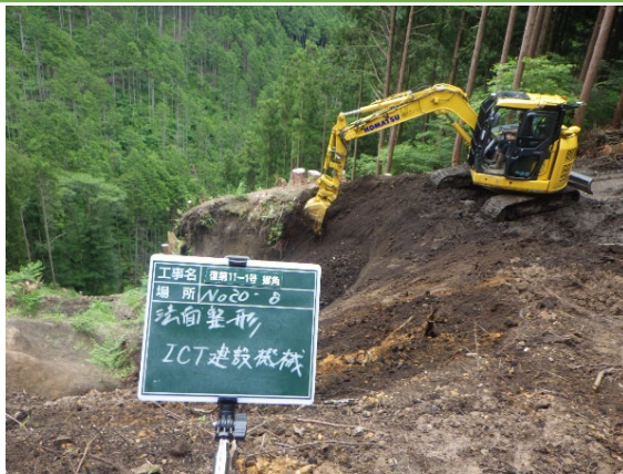
MGバックホウによる掘削（法切工）状況
