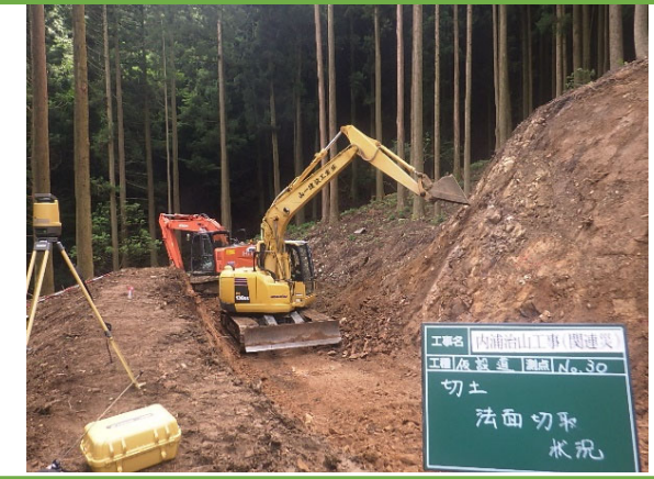
ICT建機施工
