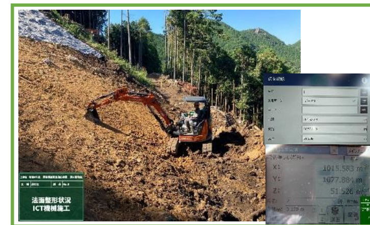
ICT (MG) バックホウによる法切
