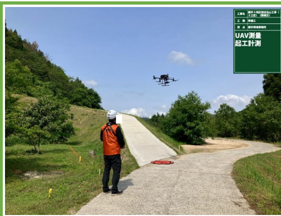
UAVによる3次元起工測量
