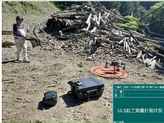
ULS測量状況
