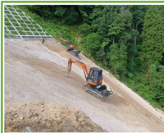
MG法面掘削機による掘削作業
