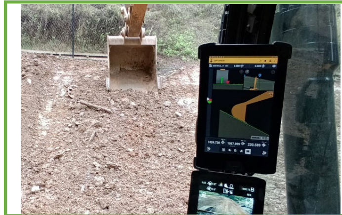
ICT土工施工時モニター
