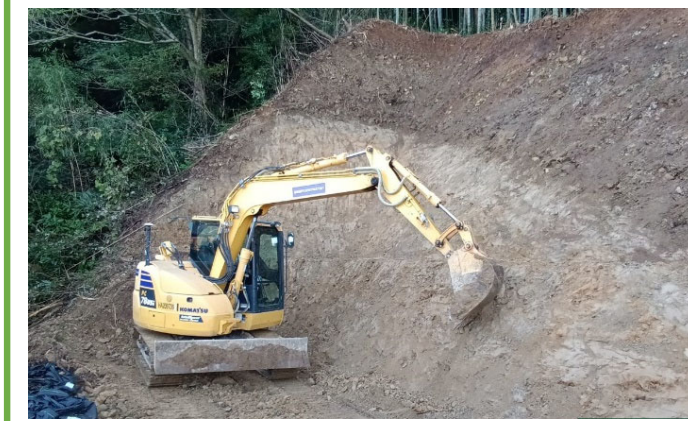
ICT法面整形状況
