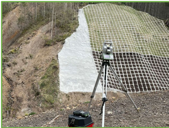
地上型レーザースキャナによる起工測量
