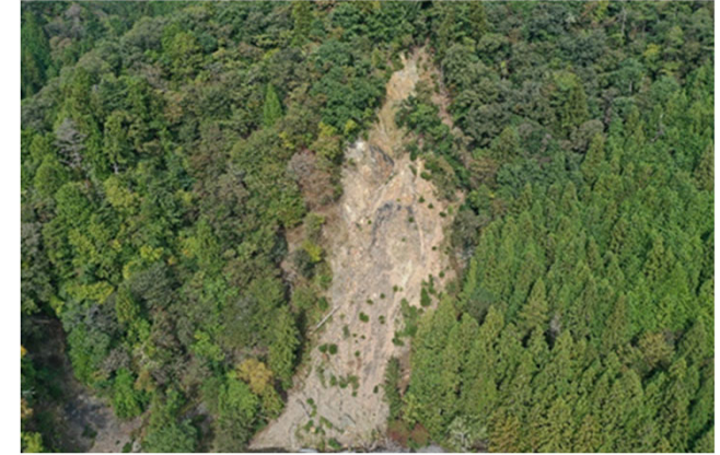
現地状況（空中写真）
