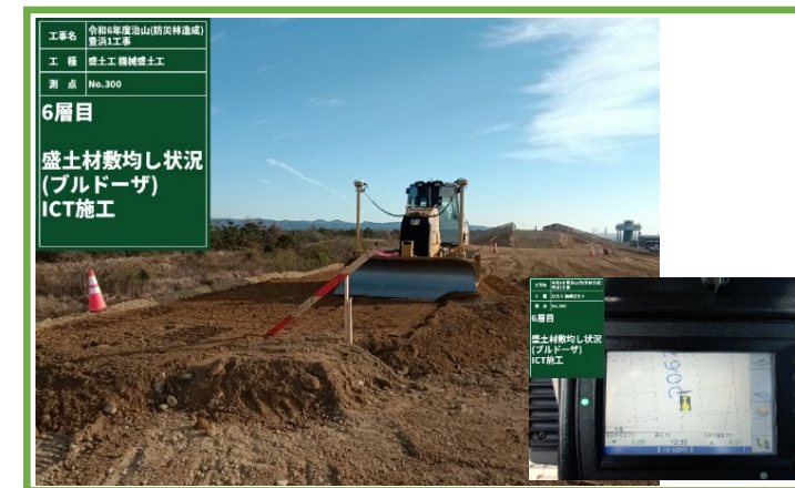
MCブルドーザーによる敷き均し
