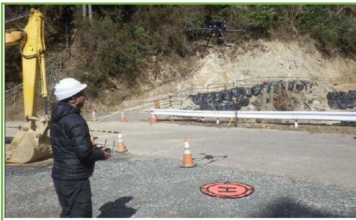
ドローンによる測量
