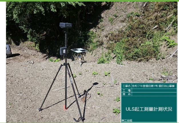
ULS測量状況
