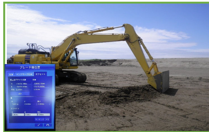
MCバックホウによる掘削
