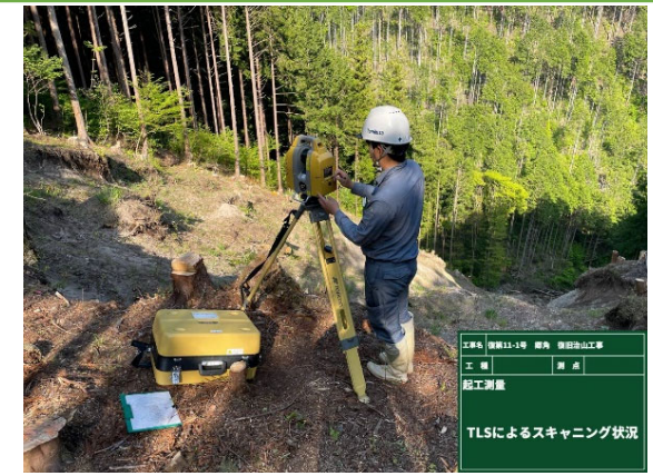
地上型レーザースキャナーによるスキャニング状況
