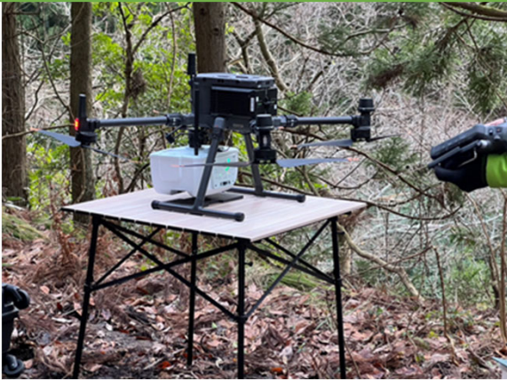
UAVによる3次元起工測量(基準点確認)
