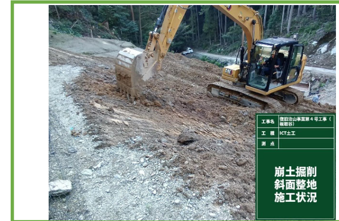
ICT土工 掘削・法面整形施工状況
