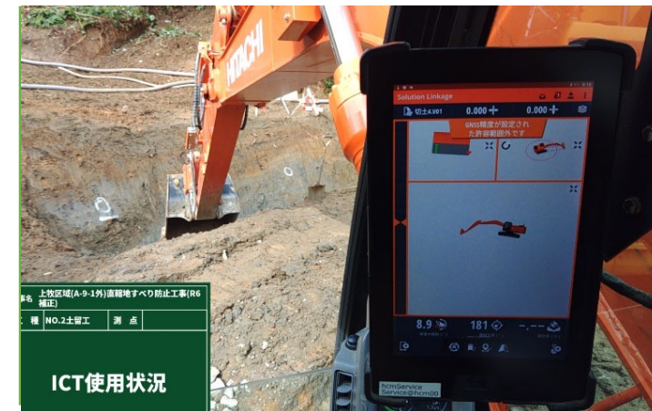
掘削状況 (ガイダンス)
