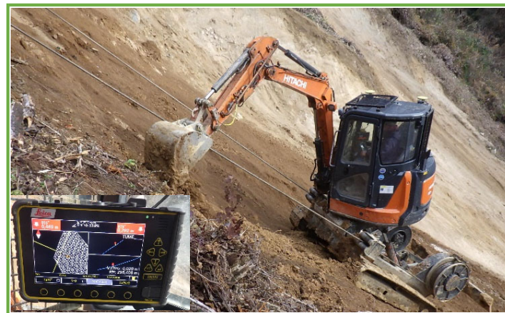
マシンガイダンスによる法面掘削
