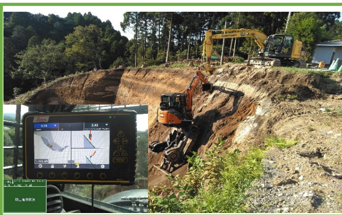
MGバックホウによる施工
