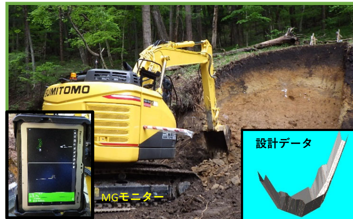
MGバックホウによる掘削
