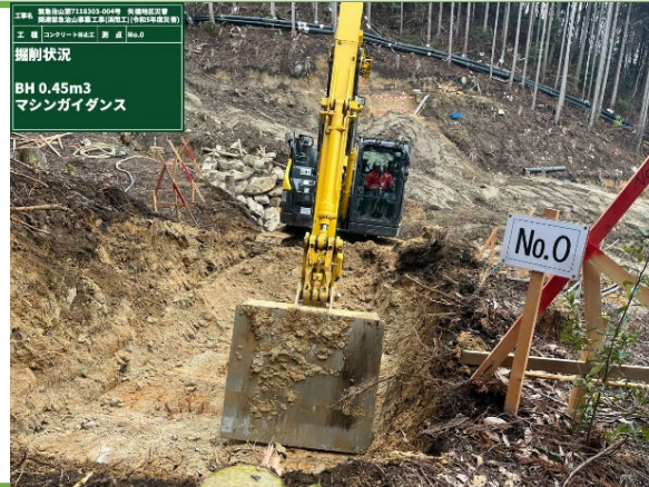
MGバックホウによる施工
