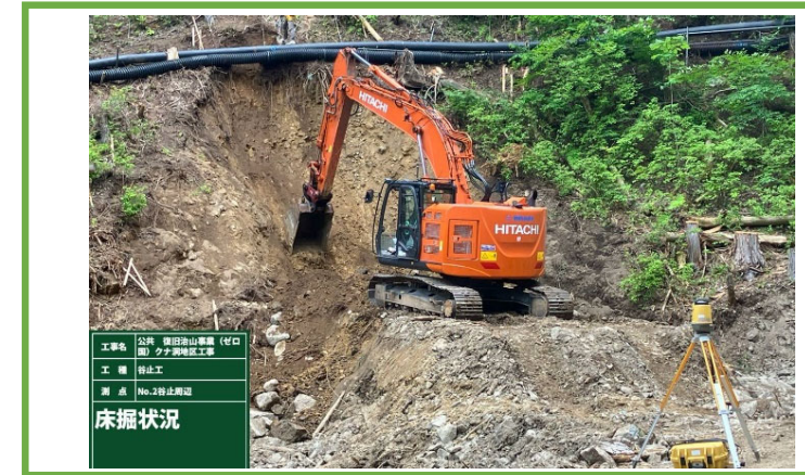
谷止工の掘削状況
