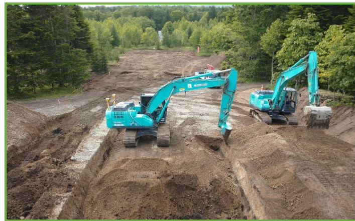
ICT建機（MCバックホウ）施工中
