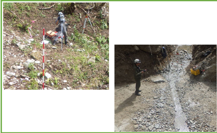
TLSによる測量
