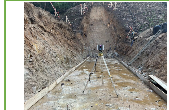
床掘出来形確認
