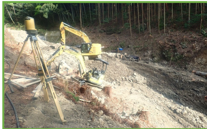
杭ナビ設置状況
