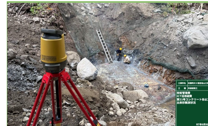
3次元データを用いた出来形管理状況
