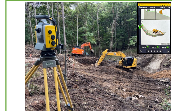
MG・MCバックホウによる掘削
