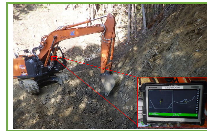
MGバックホウによる床掘及びモニター状況
