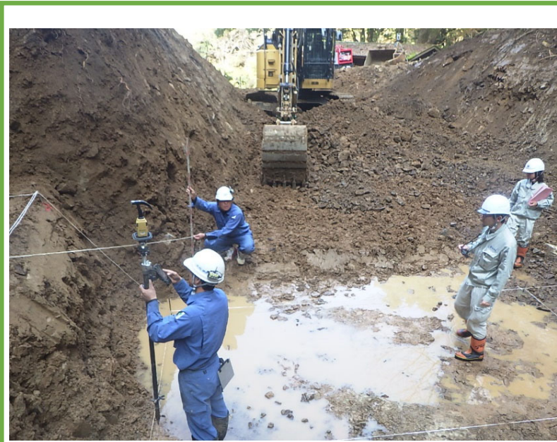
自動追尾TSによる床掘確認
