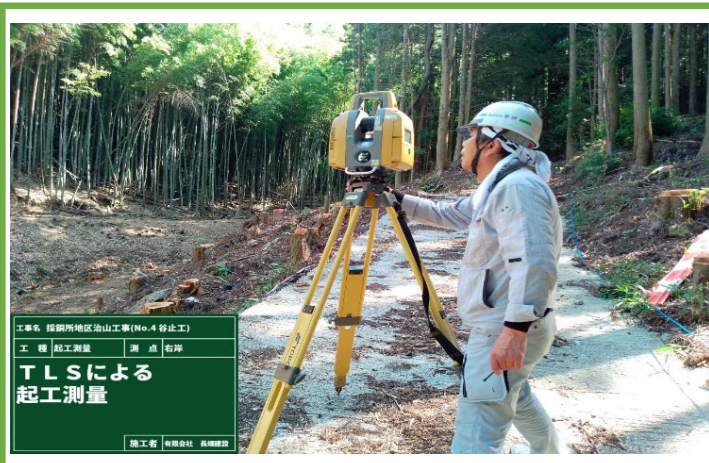
地上型レーザースキャナーを用いた起工測量
