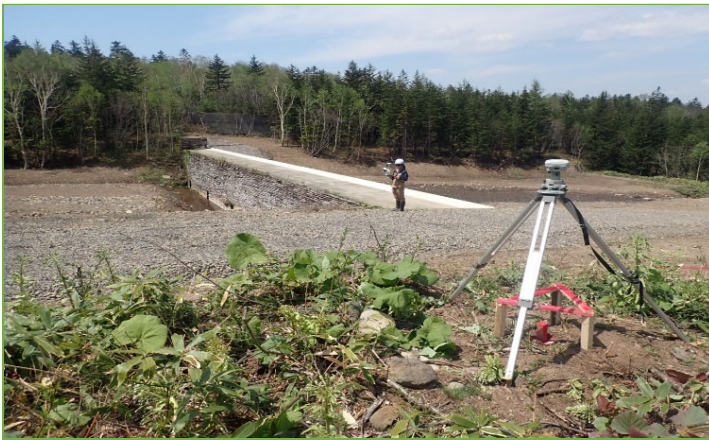
レーザースキャナによる起工測量（計測状況）
