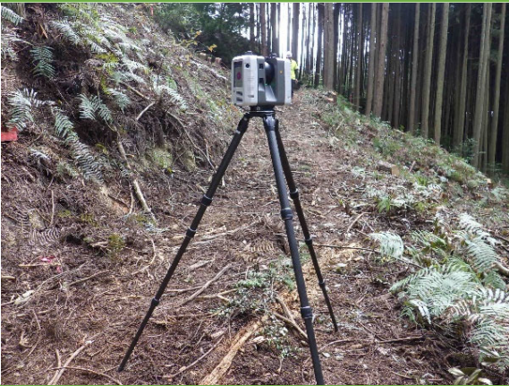
地上型レーザースキャナーによる起工測量
