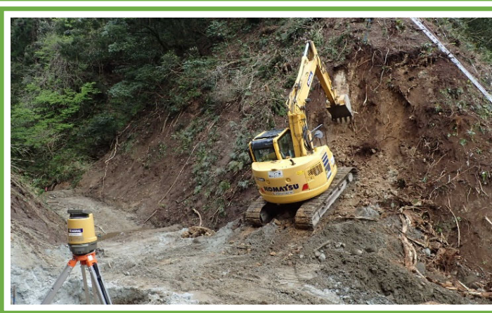
MGバックホウによる掘削作業
