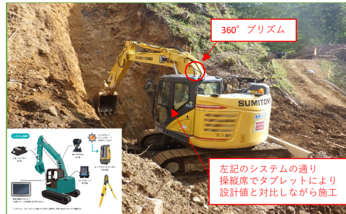
谷止工 掘削状況
