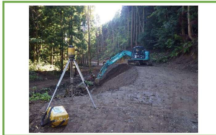
MGバックホウによる法面整形作業
