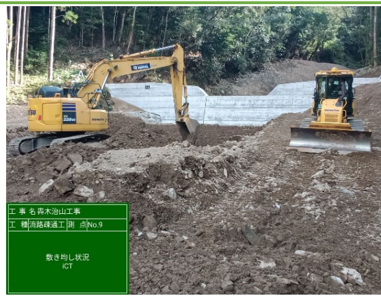
施工状況（盛土・法面整形）
