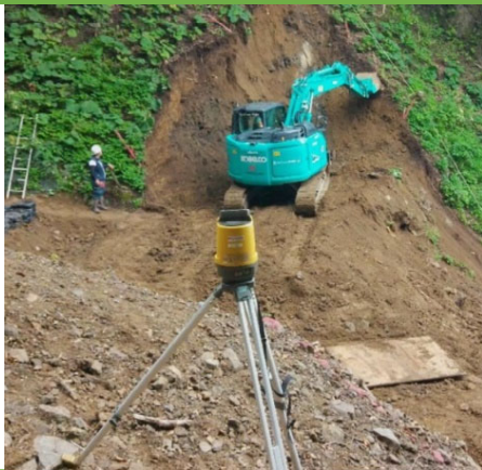
掘削作業状況
