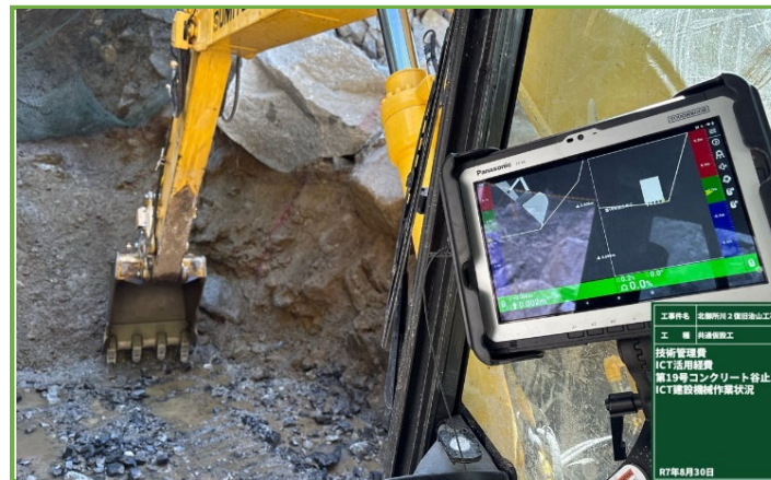
マシンガイダンスによる土工の施工状況
