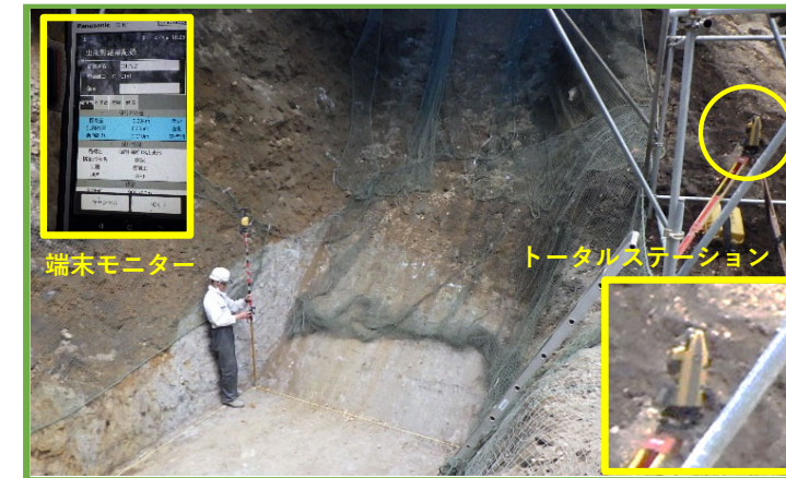
掘削工出来形計測
