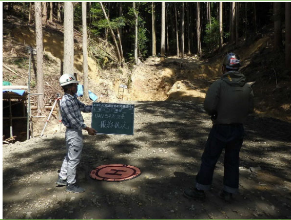
UAV出来形測量撮影状況
