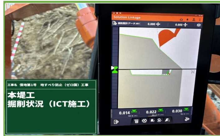
タブレット端末による掘削
