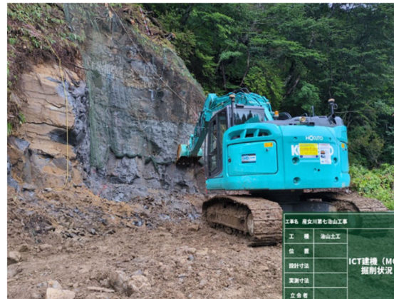
ICT建機による掘削状況
