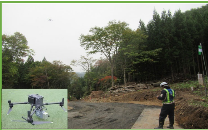
UAVによる起工測量状況
