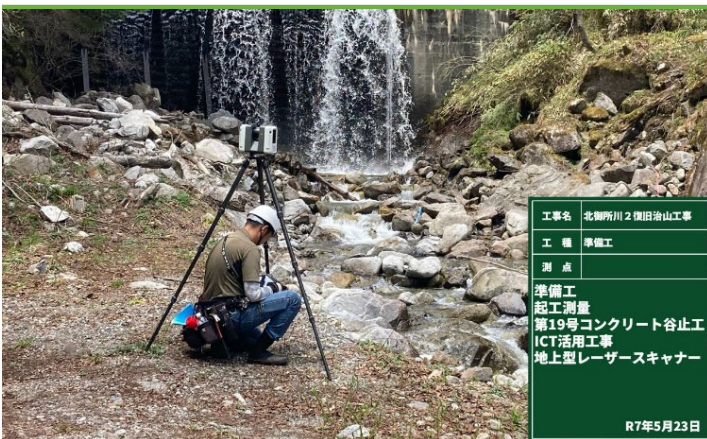
地上型レーザーを用いた起工測量
