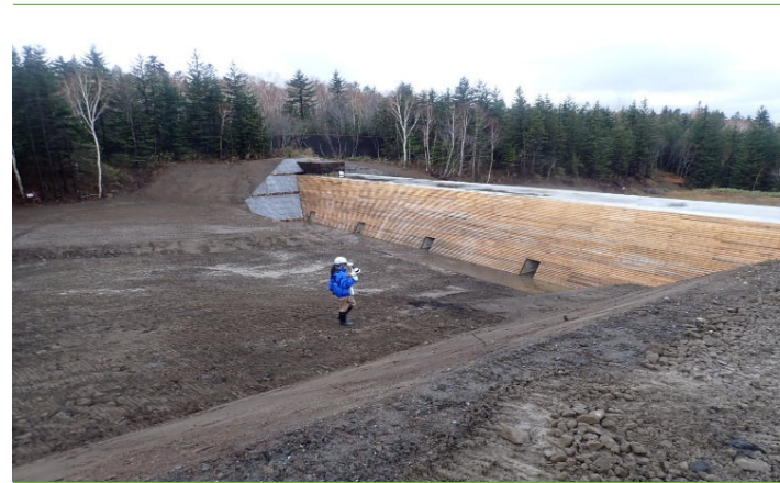
レーザースキャナによる出来形管理（計測状況）
