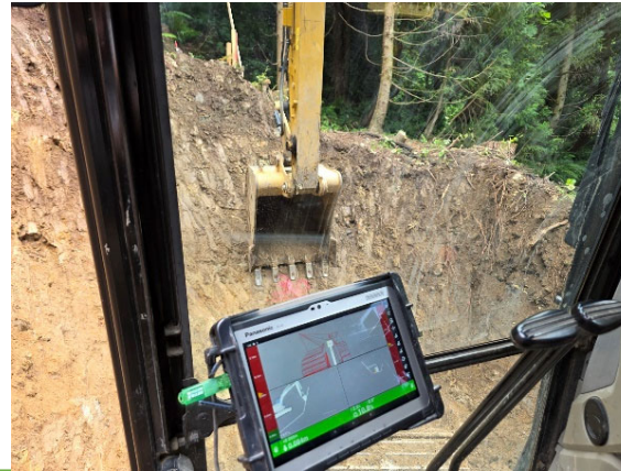
MGバックホウによる掘削
