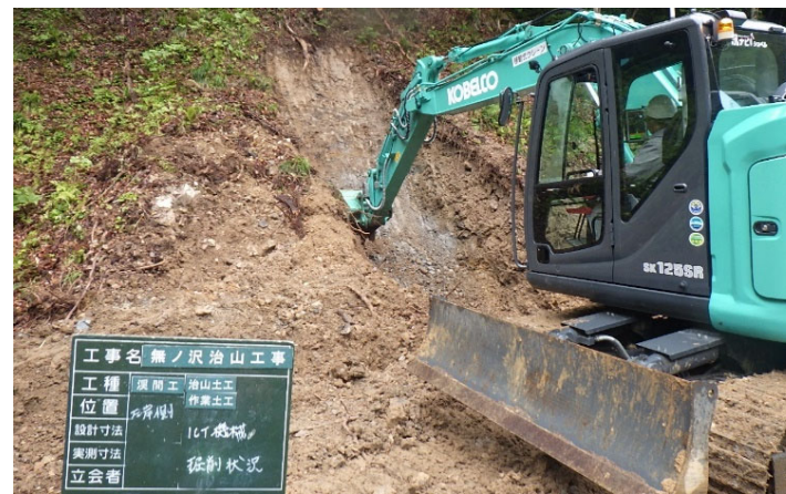
MGバックホウによる掘削作業
