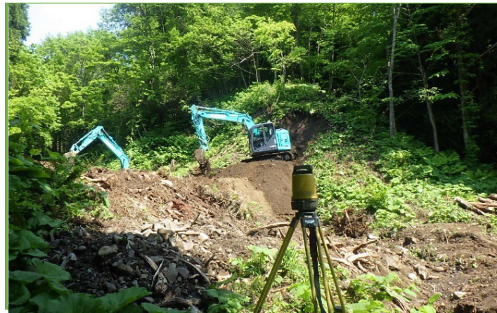
MGバックホウによる掘削作業
