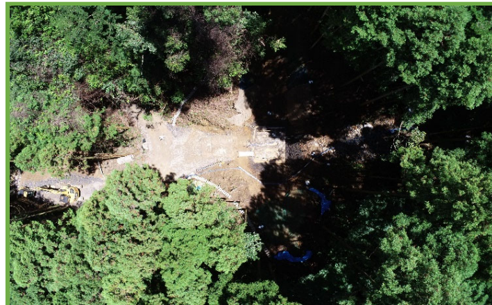
無人航空機による施工箇所撮影
