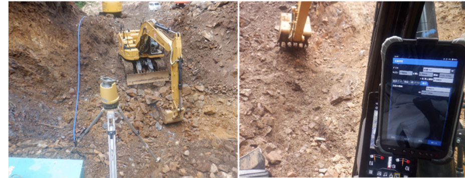
マシンガイダンスによる掘削状況及び表示状況
