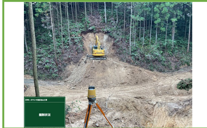
MGバックホウによる掘削
