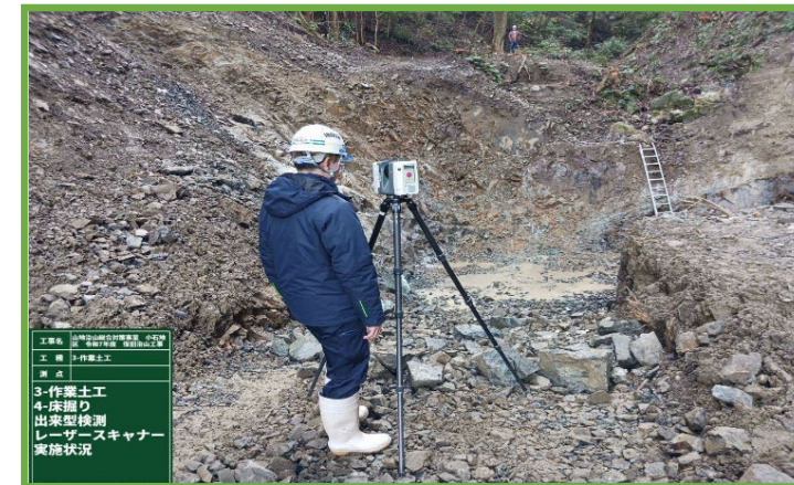
地上型レーザースキャナーを用いた出来形検測
