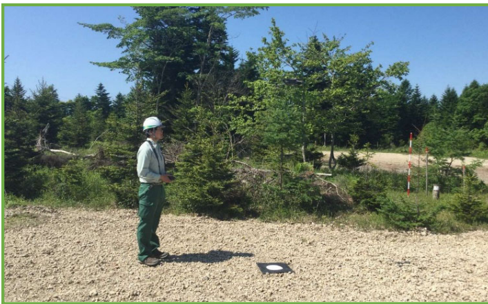
UAVによる起工測量
