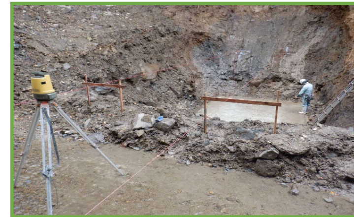
杭打ちナビによる測量状況
