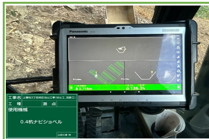
3次元データで高精度な掘削
