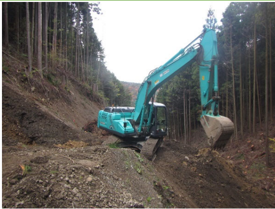
MGバックホウによる掘削
