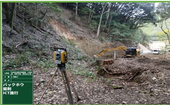
MCバックホウによる掘削作業
