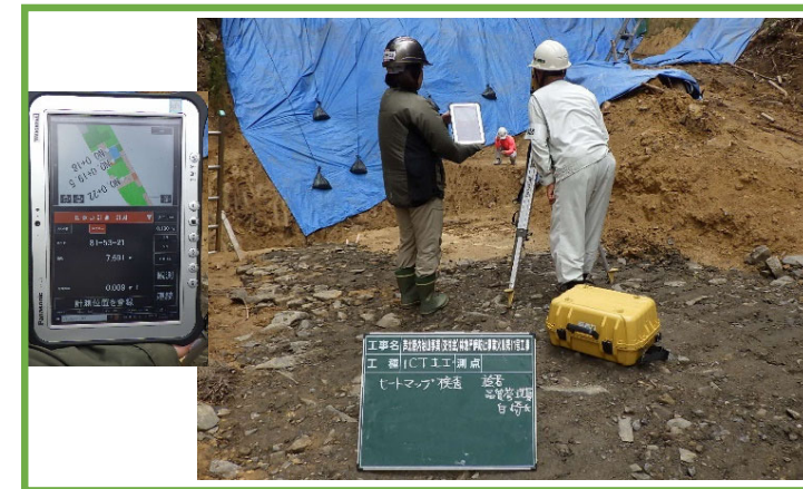
ヒートマップ検査(確認検査)
