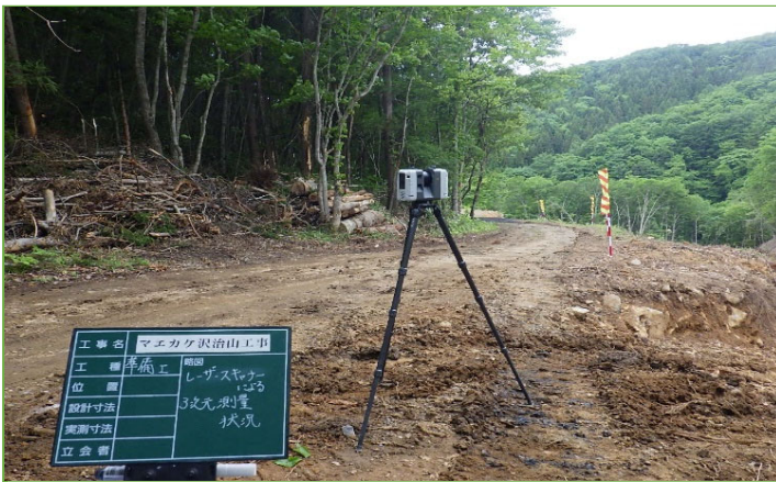
3次元起工測量実施状況
