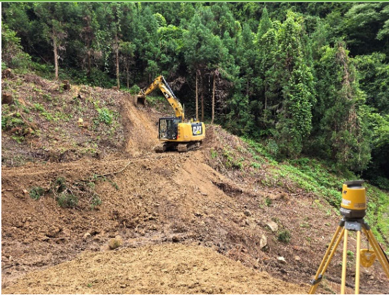
地上型レーザースキャナーによる 3次元起工測量
