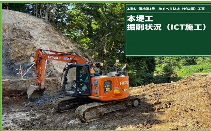
MGバックホウによる掘削作業
