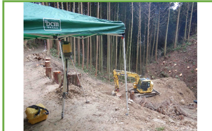
MGバックホウによる掘削
