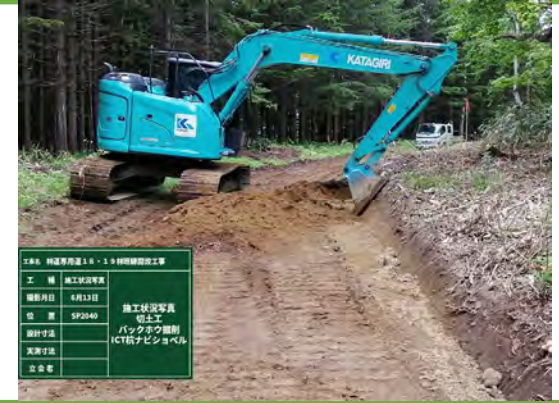
杭ナビシヨベルによる掘削・整形
