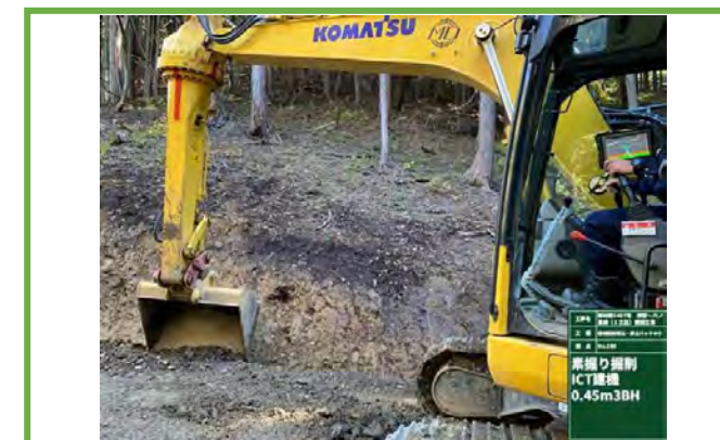
設計データを確認した側溝切り取り
