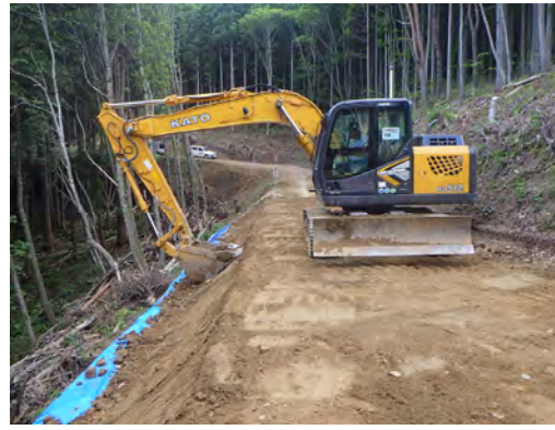
MGバックホウによる法面整形（盛土）
