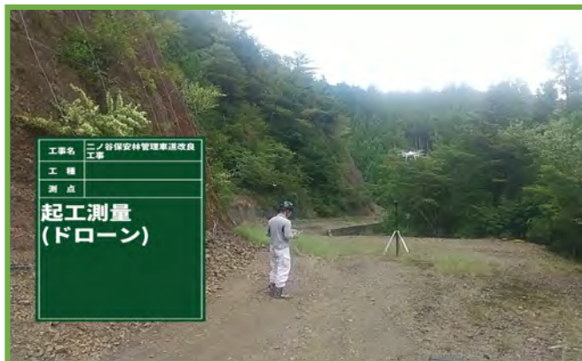
UAVによる3次元起工測量
