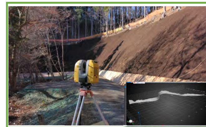
TLSによる3次元出来形測量
