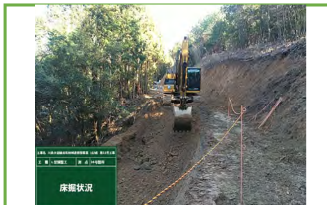
MGバックホウによる掘削（床掘）
