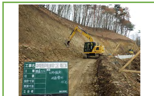
MCバックホウによる施工
