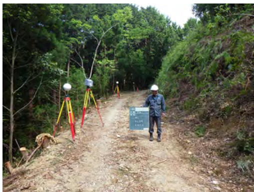
3次元測量実施状況
