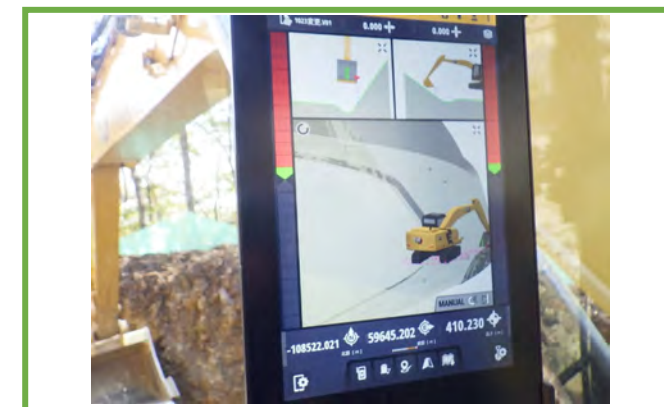
施工時のモニター
