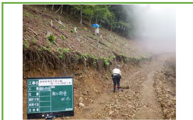
TLSによる起工測量
