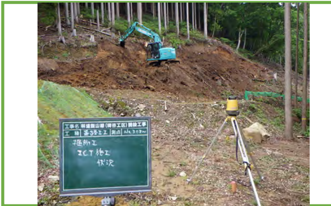
地上型レーザーキャナーにより掘削法面とバックホウのショベル先端の位置関係を管理
