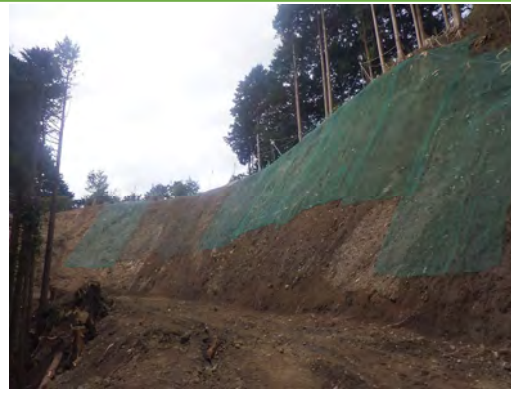
ICT建機による掘削完了状況
