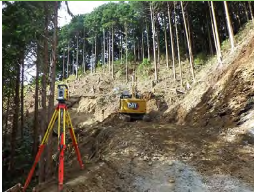
ICT建機による掘削状況
