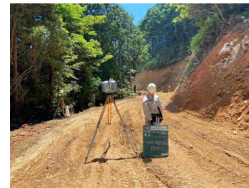
出来形測量（TLS）状況
