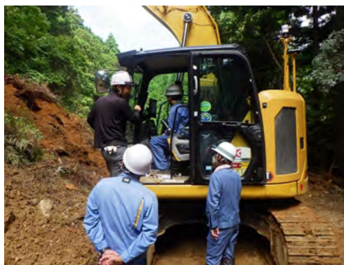
掘削状況確認 マシンコントロール確認
