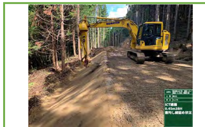
MGバックホウによる盛土法面整形
