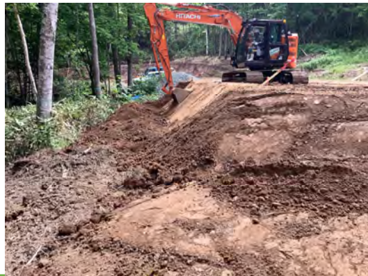
丁張を設置し、誤差などの比較検討を実施
