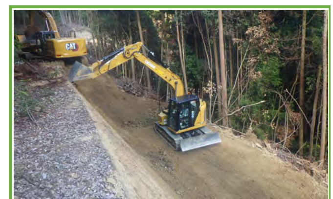
ICT建機による法面掘削
