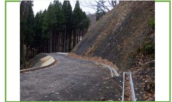
掘削・盛土法面出来栄
