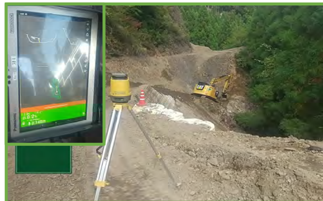
MGバックホウによる施工
