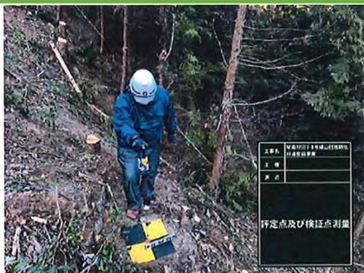
3次元起工測量の精度確認試験
