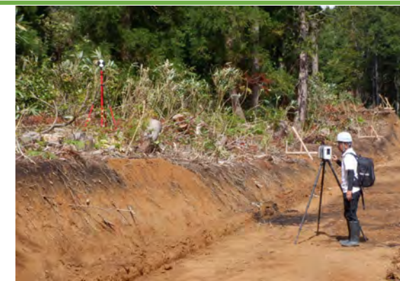
TLSによる出来形計測状況
