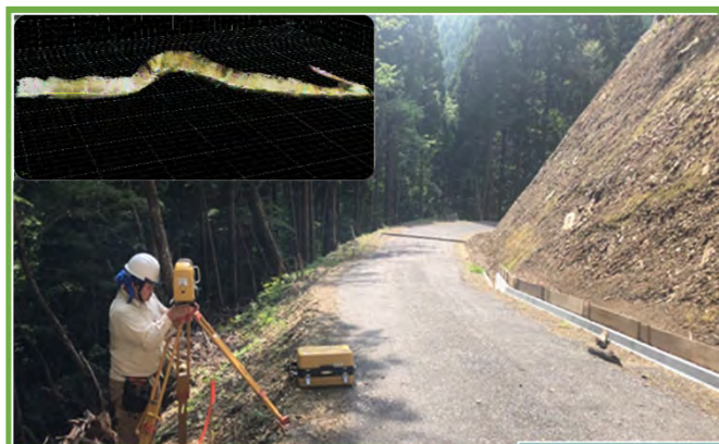
TLSによる3次元起工測量
