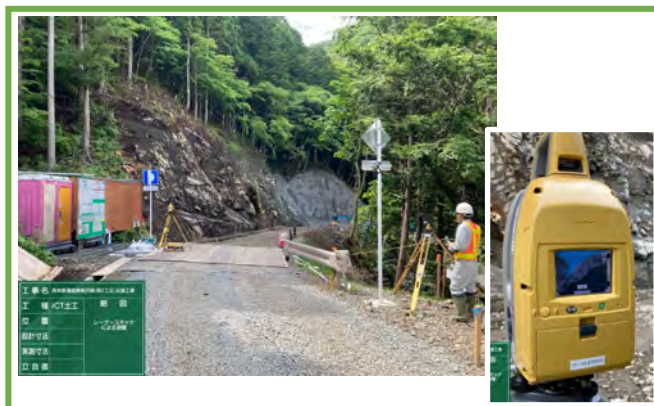
TLSによる測量
