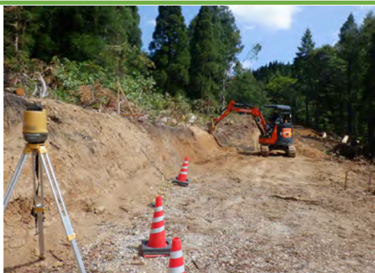
MG機械掘削
