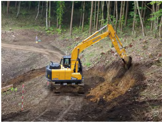
MGバックホウによる掘削（切土）
