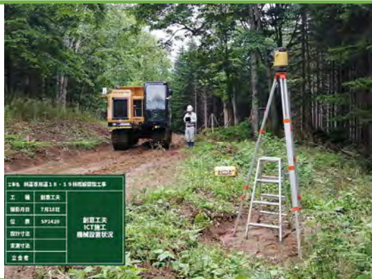
自動追尾式TSによる起工測量
