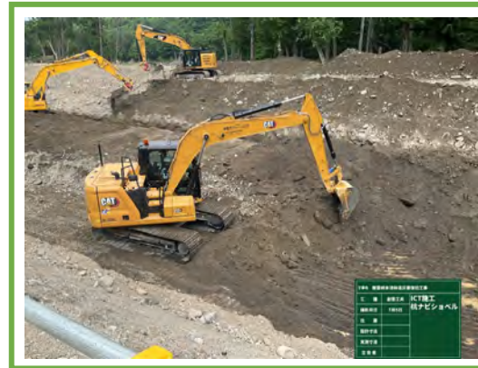
擁壁工 機械床堀状況
