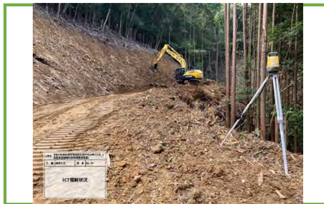
MG機械掘削状況
