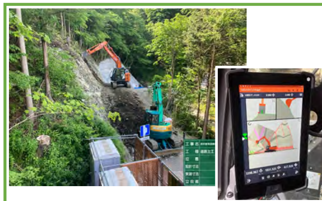
MCバックホウによる施工 【自動追尾型TLS】
