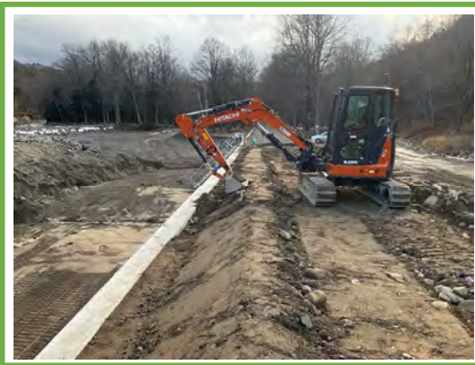
盛土法面整形状況
