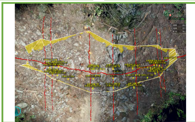
ドローン写真測量による起工測量
