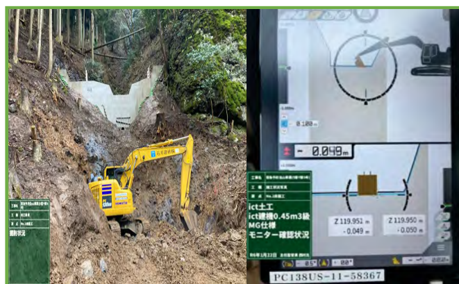
MGバックホウによる掘削作業
