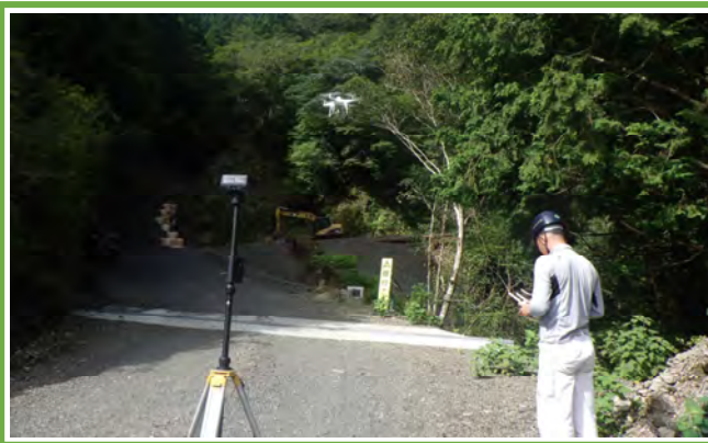
UAVによる3次元起工測量
