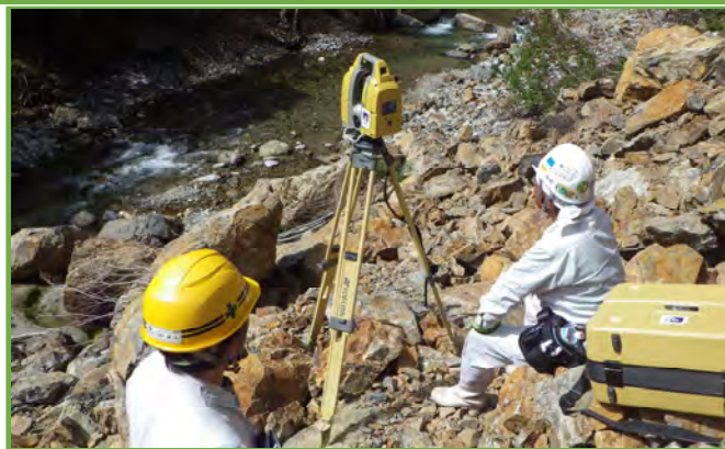
TLSによる測量
