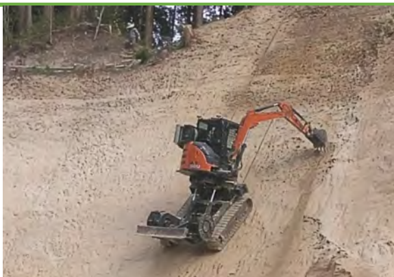
掘削・整形状況
