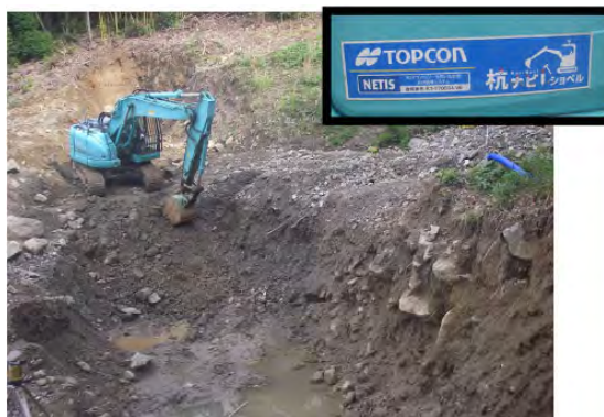
ICT建機による床掘作業
