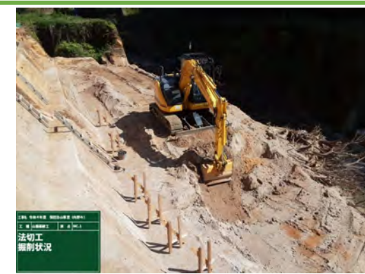
ICT建機による掘削状況
