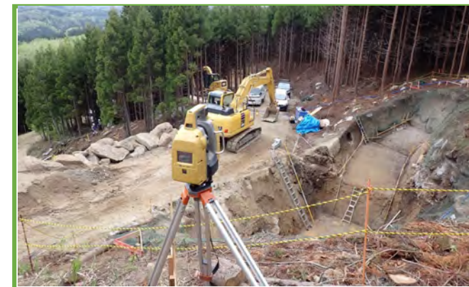
地上レーザースキャナーによる出来形測量
