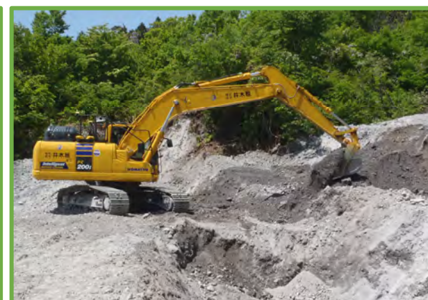
ICT建機による掘削作業状況
