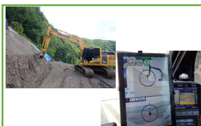
MG付きバックホーによる掘削
