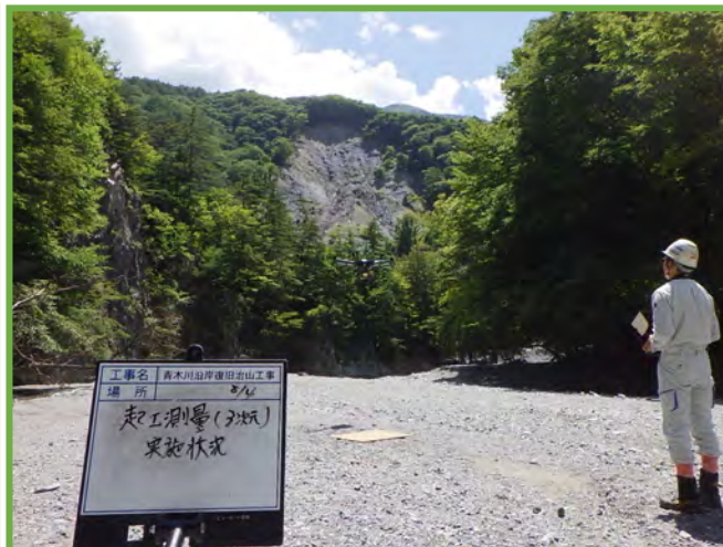
UAVによる起工測量の状況
