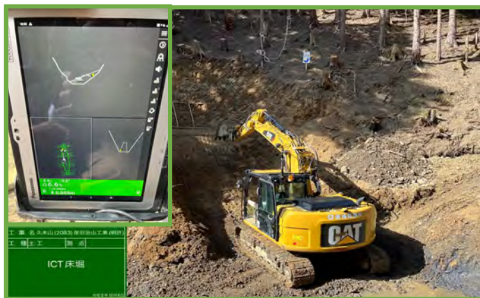
MGバックホウによる施工
