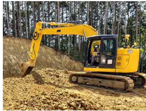
法面整形作業
