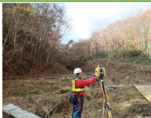
地上レーザースキャナーによる測量状況
