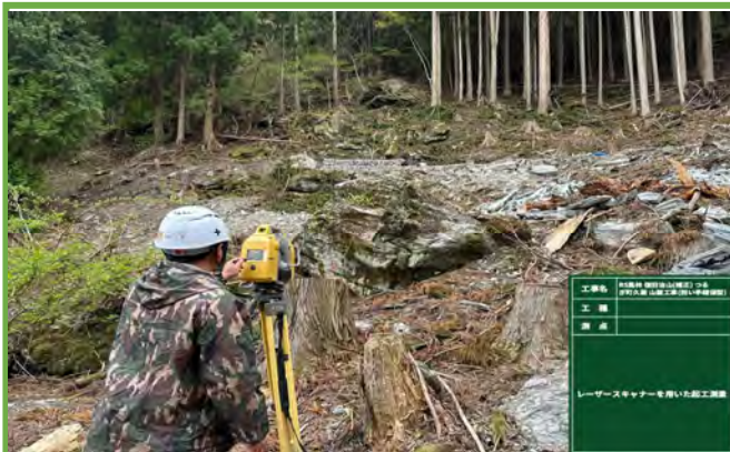
地上型レーザースキャナー起工測量状況
