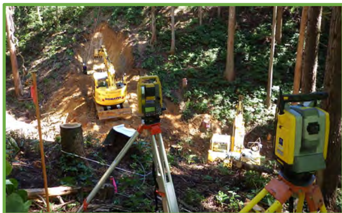
MCバックホウによる掘削
