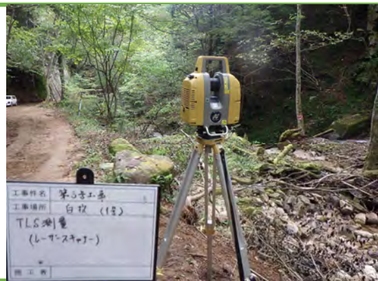
レーザースキャナーによる起工測量状況
