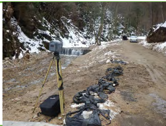
レーザースキャナーによる出来形計測状況
