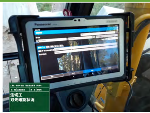
ICT建機刃先位置の確認状況
