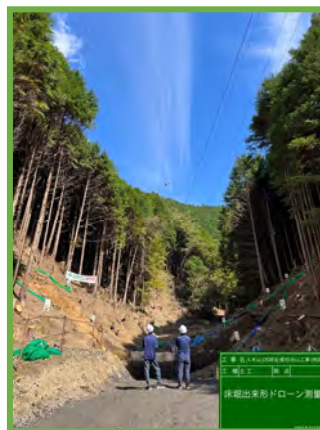
UAVによる3次元出来形計測
