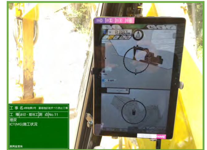
ICT (MG) バックホウによる掘削
