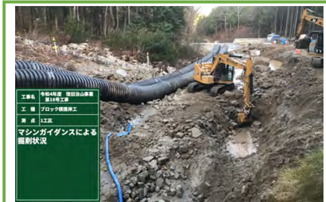
MGバックホウによる掘削
