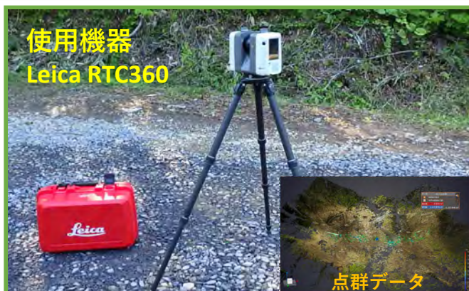
TLSによる起工測量
