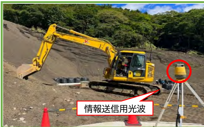
ICT建機による床掘状況
