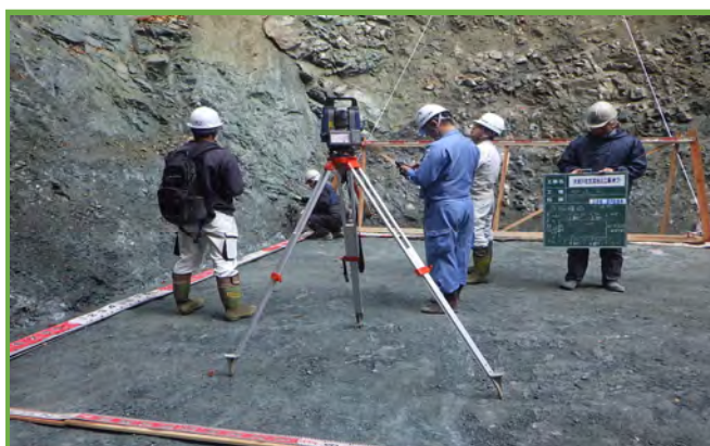
TSによる掘削床堀面の出来形測定
