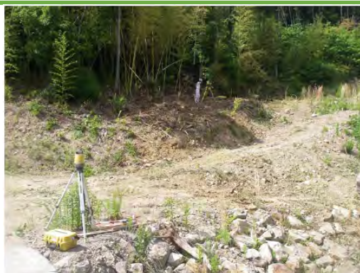
着手前レーザースキャナ測量
