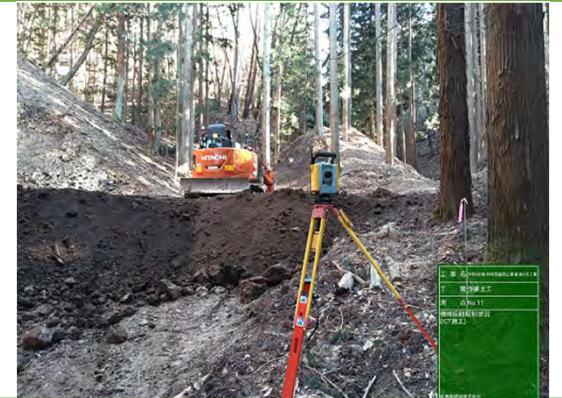
MGバックホウによる床掘
