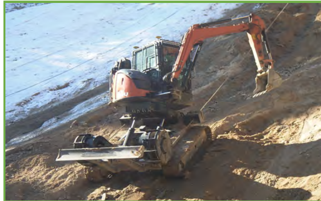
ICT掘削状況
