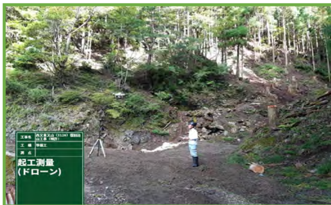
UAVによる3次元起工測量
