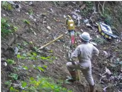
地上レーザを活用した起工測量
