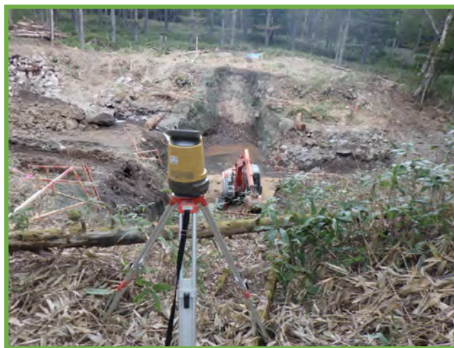
MGバックホウによる床掘
