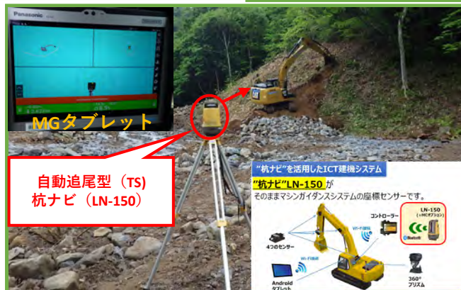
ICT建機による作業状況 自動追尾型TS活用 (BH0.8m 3 級)
