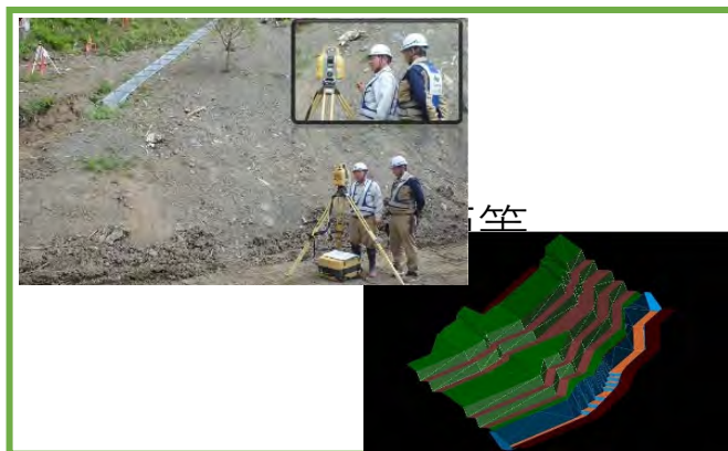
3次元起工測量・設計データ作成
