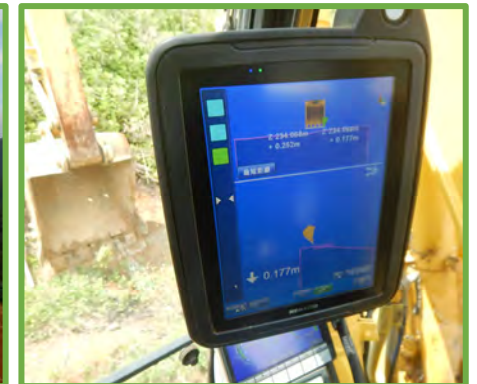
ICT建機内のモニター画像 (バケット位置確認)
