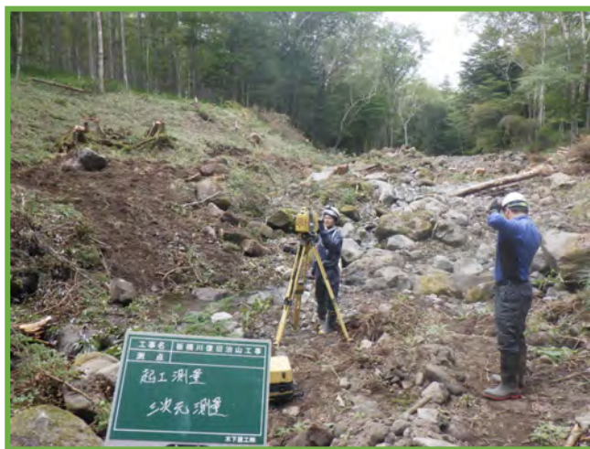
地上型レーザー scanner による起工測量
