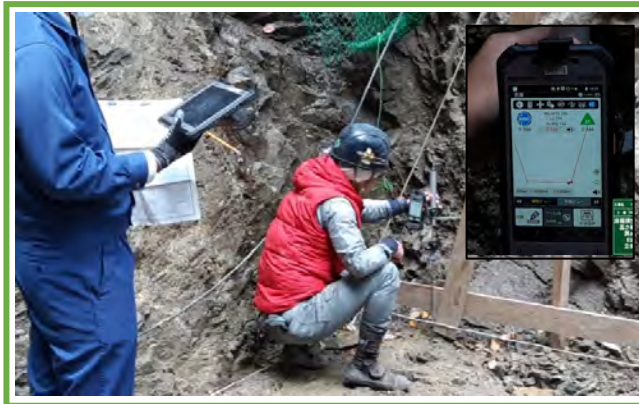
谷止工床掘完了確認状況
