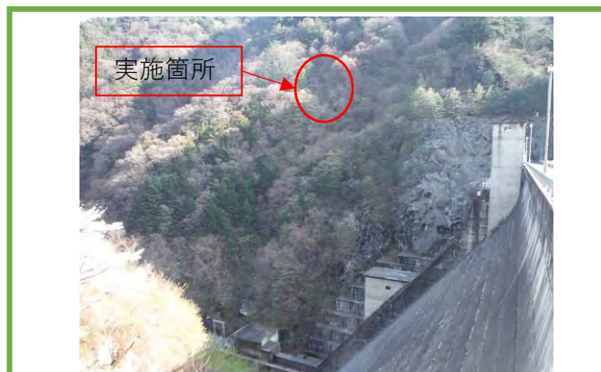
UAVレーザ実施箇所
