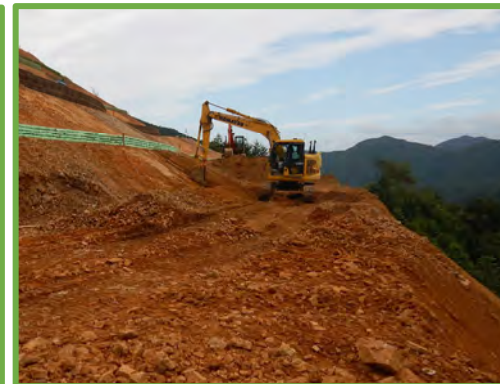
ICT建機による掘削作業状況
