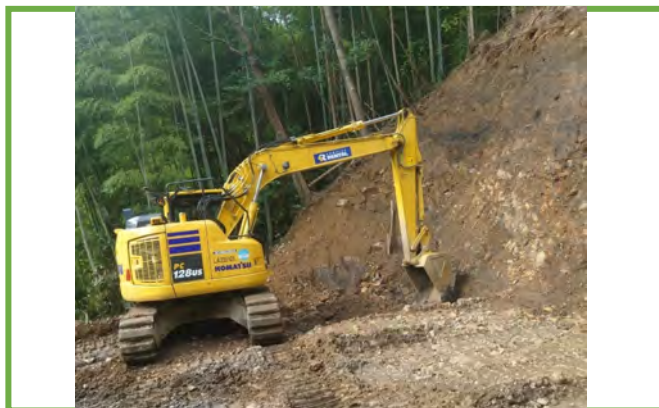
MGバックホウによる掘削状況
