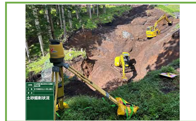
鋼製枠谷止工 床堀状況
