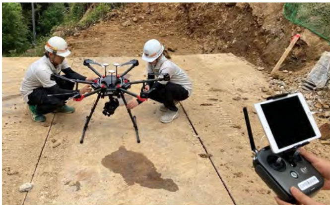
無人航空機による起工測量
