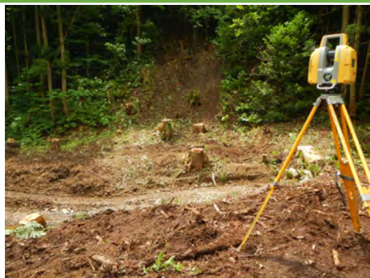
レーザスキャナによる起工測量
