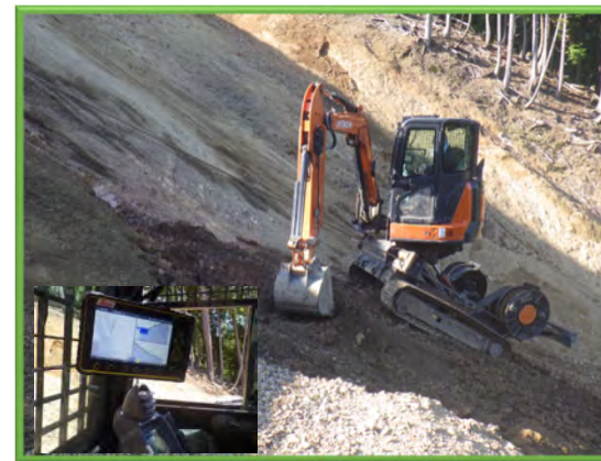
ICT建機による作業状況 (MG付き高所斜面掘削機械)
