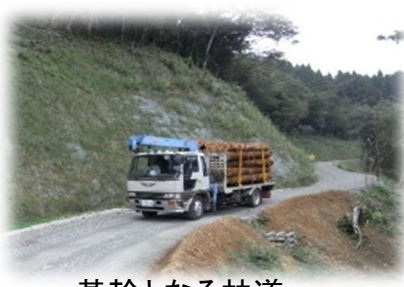
基幹となる林道
