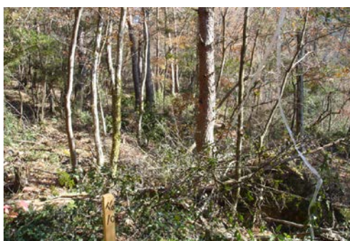
現場の状況（作業前）
