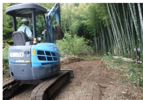
作業道の整備
