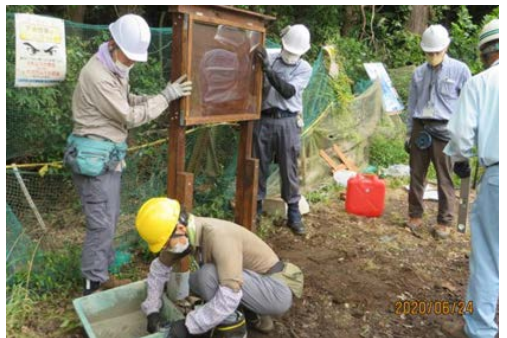
掲示板の設置作業
