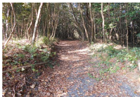
除伐、拡幅して整備した林内作業道
