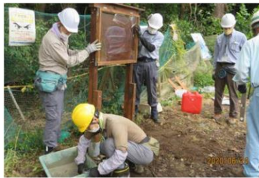
掲示板の設置作業
