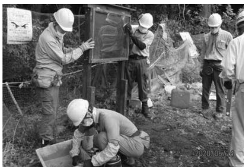
掲示板の設置作業
