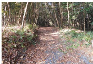
除伐、拡幅して整備した林内作業道
