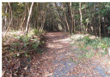
除伐、拡幅して整備した林内作業道
