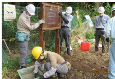
掲示板の設置作業
