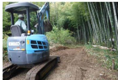
作業道の整備
