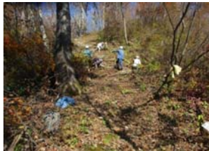
階段状に登山道を整備 (作業実施中)
