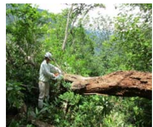
倒木撤去 (作業実施中)
