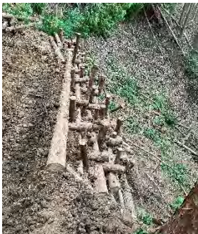
伐採木の一部は作業道整備の土留めに活用
