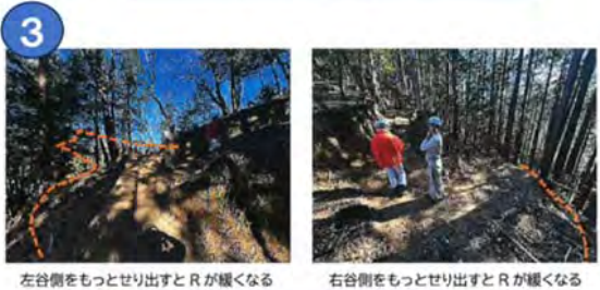
ヘアピンカーブの施工
