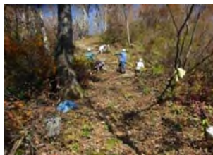
階段状に登山道を整備 (作業実施中)
