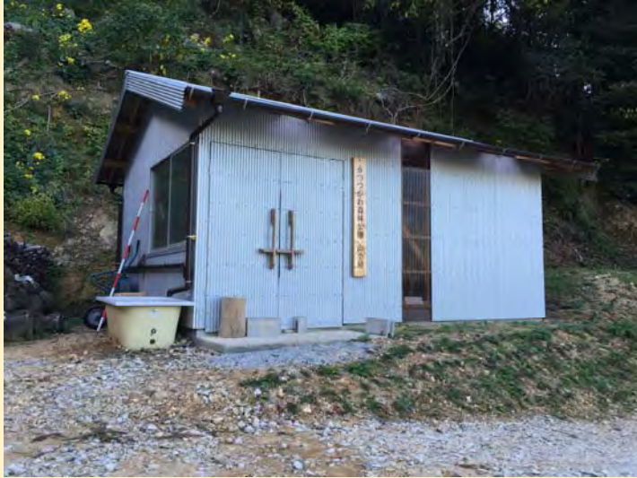
山小屋の設置
