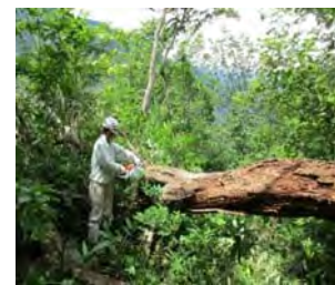
倒木撤去 (作業実施中)
