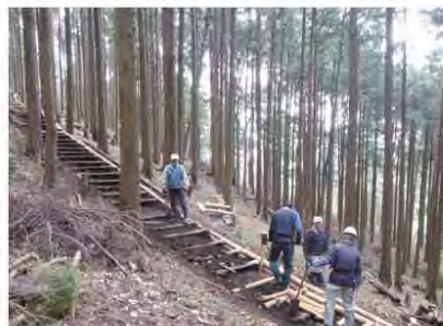
歩道の補修作業
