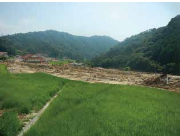
土砂氾濫堆積状況（遠景）
