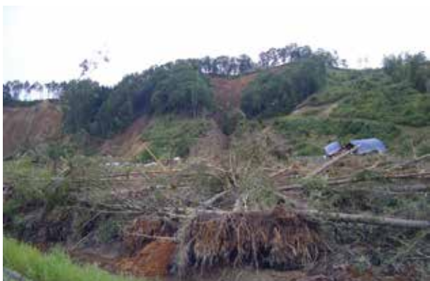
浅い谷と山腹の崩壊状況
