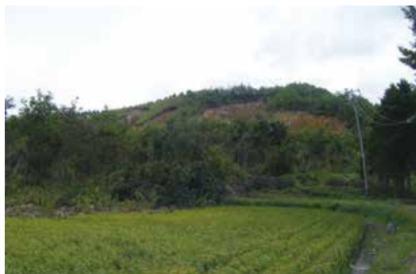
崩壊土砂の末端部分
