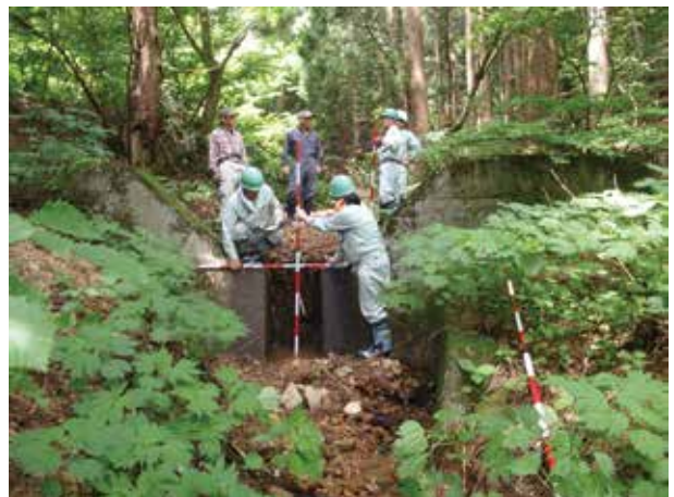
施設点検（富山県富山市）
