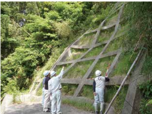
施設点検（徳島県三好市）
