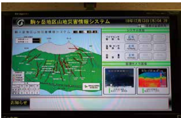
監視システム画面
