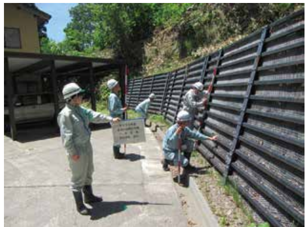
危険地域の点検（石川県金沢市）
