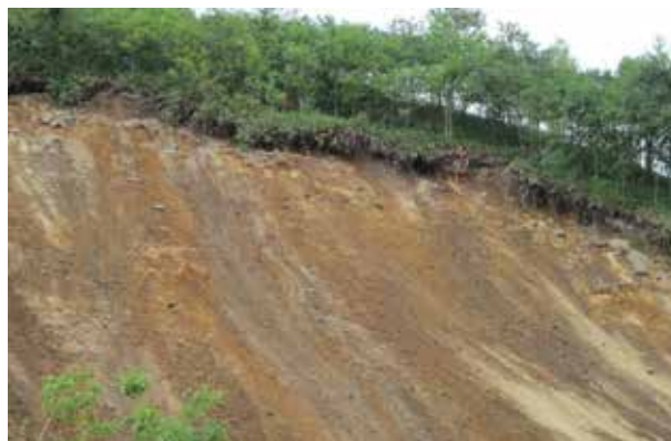
右側の平坦な地形での崩壊箇所
