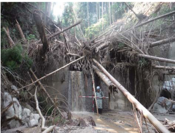
治山ダム（3基目）全景
