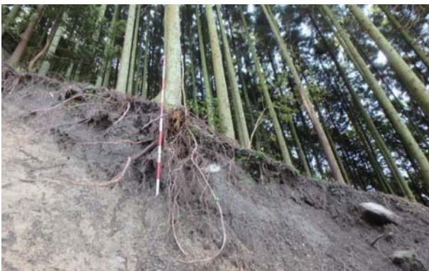
崩壊地内縁の根系
