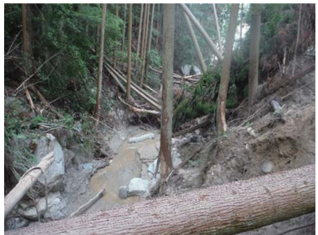
治山ダム（2基目）堆砂域の状況
