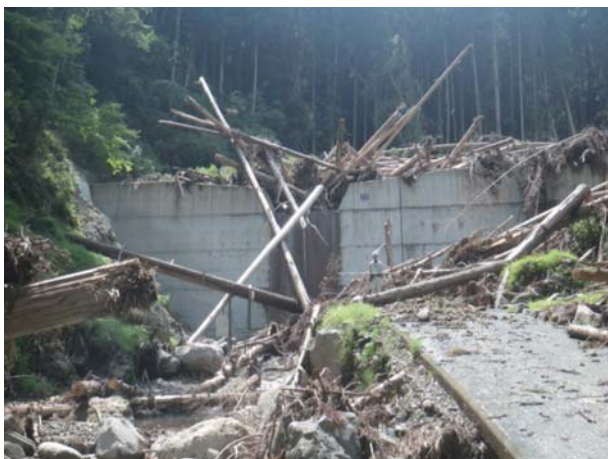
治山ダム（1基目）全景
