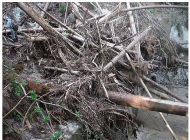
治山ダム（3基目）堆砂域の状況
