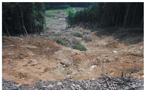
崩壊箇所源頭～下方
