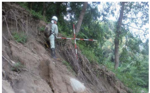
崩壊箇所源頭～下方
