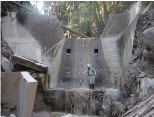
治山ダム（1基目）全景
