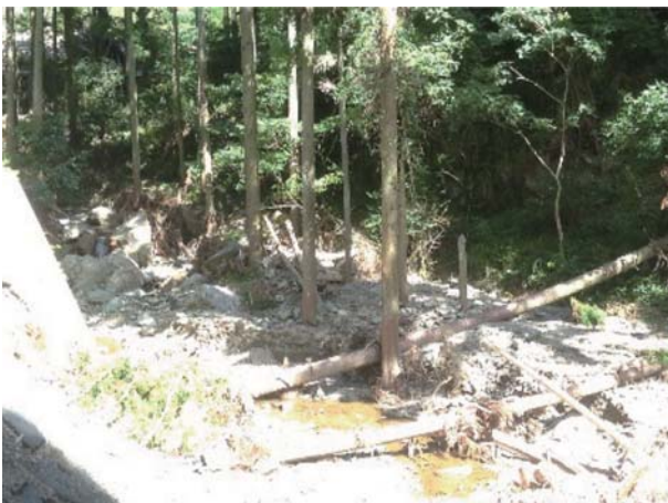
流路部に生育している流木（植栽されたスギが生育）
