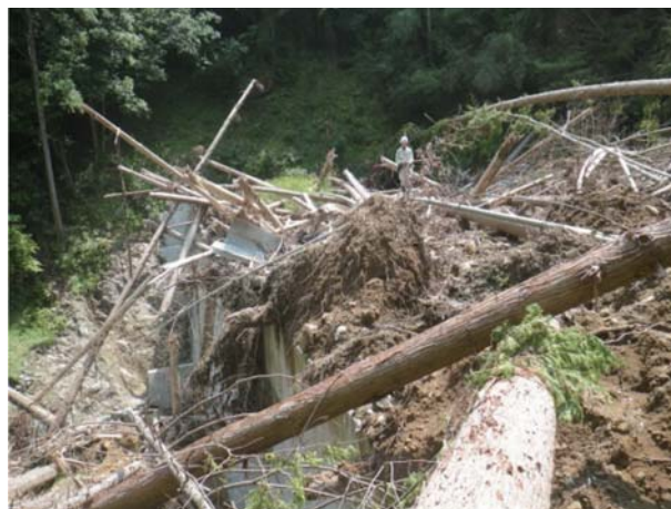
治山ダム（1基目）堆砂域の状況
