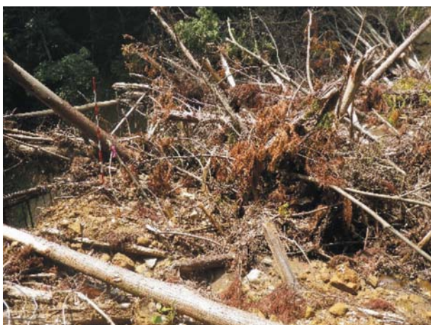
治山ダム堆砂域の状況
