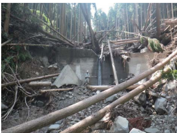
治山ダム（2基目）全景
