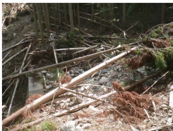
治山ダム（3基目）堆砂域の状況
