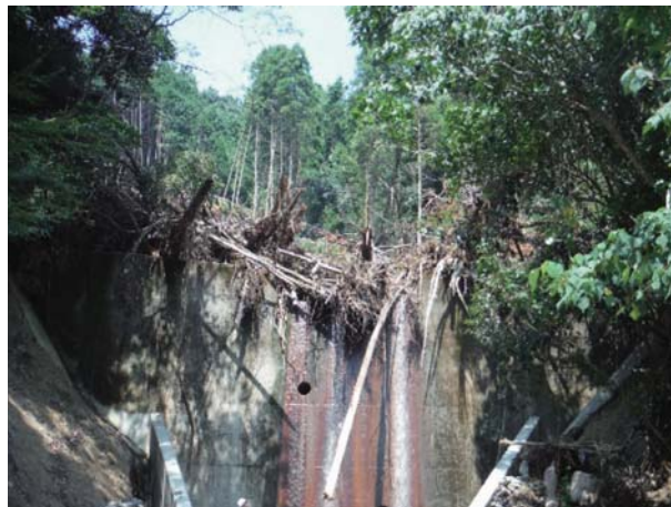
治山ダム放水路の状況
