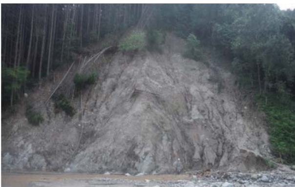
崩壊箇所源頭部
