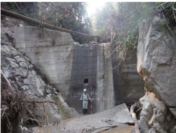
治山ダム（2基目）全景
