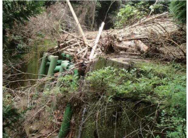
透過型治山ダム（建）堆砂域の状況
