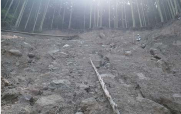
崩壊箇所源頭部
