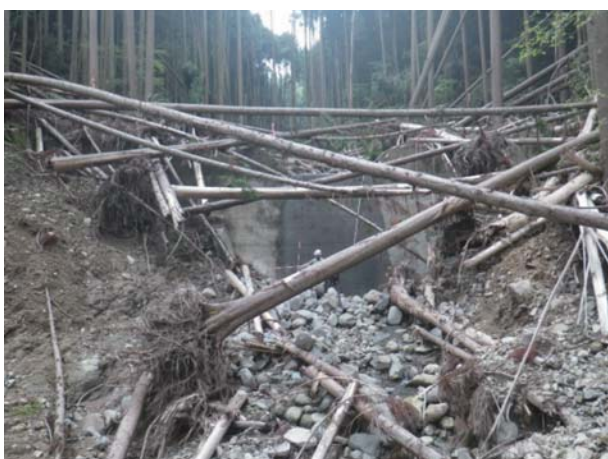
治山ダム（3基目）全景
