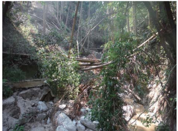
治山ダム（1基目）堆砂域の状況
