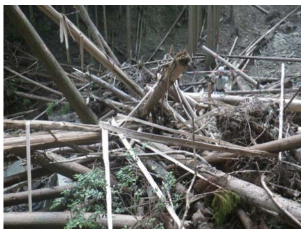
治山ダム（2基目）堆砂域の状況
