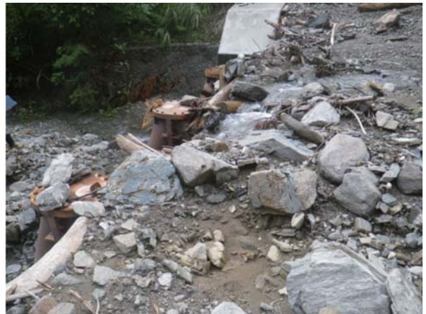
透過型治山ダム（箸立）堆砂域の状況
