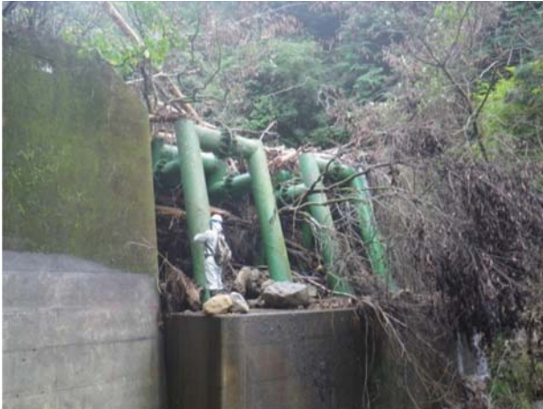
透過型治山ダム（建）全景
