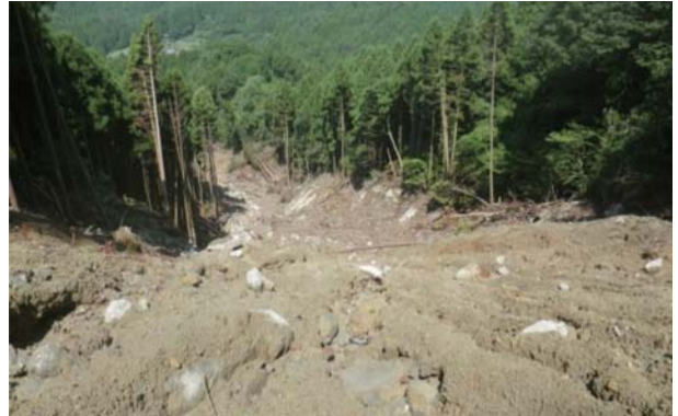
崩壊箇所源頭～下方
