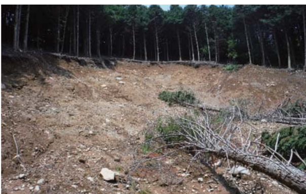
崩壊箇所源頭部
