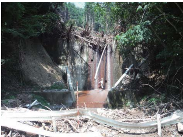
治山ダム全景
