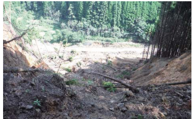
崩壊箇所源頭～下方
