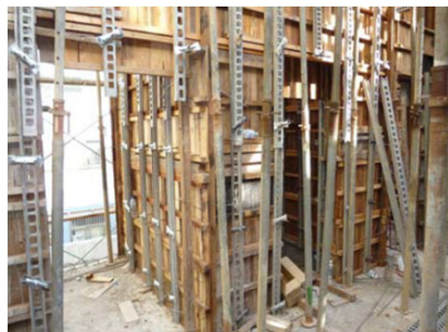
台湾で使用されているコンクリート型枠板と使用現場 日本木材輸出振興協会：台湾における木材需給と木材産業の現状と動向より
