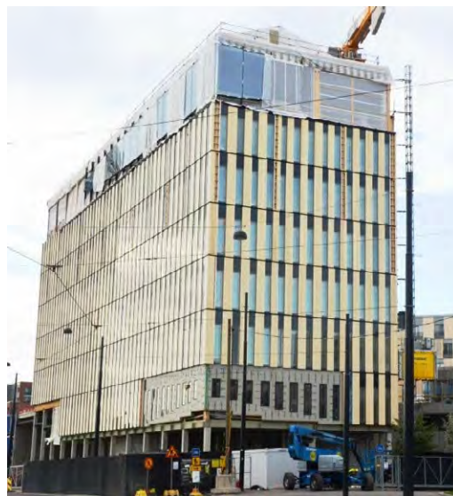
写真 6.1 建設中の木造マンション
