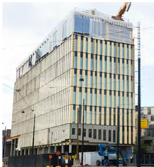
写真 6.1 建設中の木造マンション
