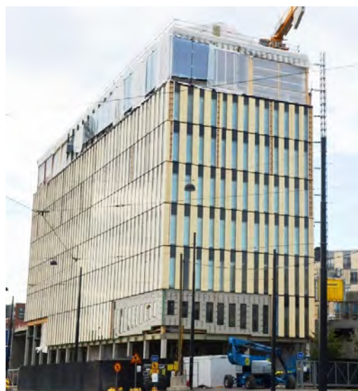
写真 6.1 建設中の木造マンション
