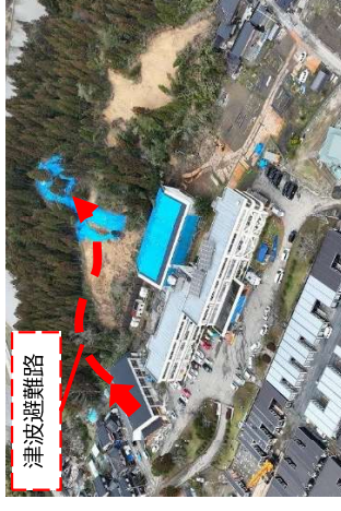
津波避難路となっている山地の被災
