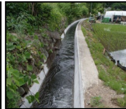
老朽化した用水路の整備・更新
