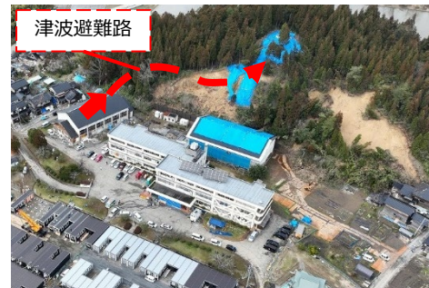
津波避難路となっている山地の被災
