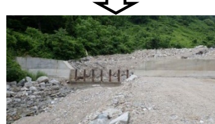
治山ダムに異常堆積した土石・流木の除去
