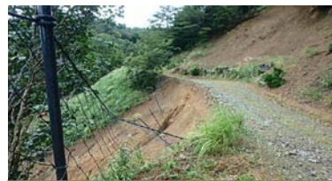
被災した森林作業道の復旧
