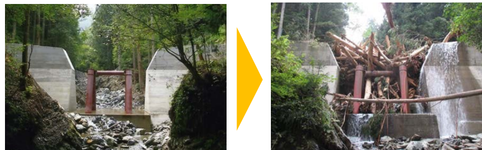
流木捕捉式治山ガムの整備
