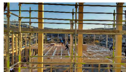
建設中の様子
