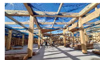
木造店舗の建設の様子
