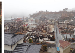
綾里港地区の被害状況
