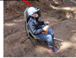
①AR技術を活用した遠隔操作
