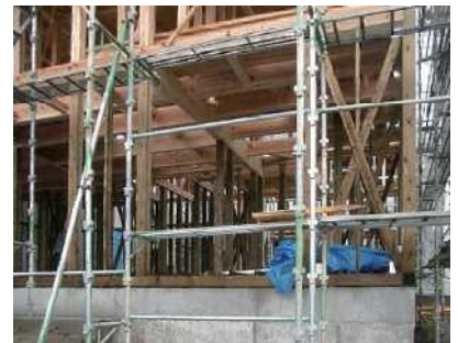
1 階部の木製部材全てに防腐剤注入を使用した住宅の例
