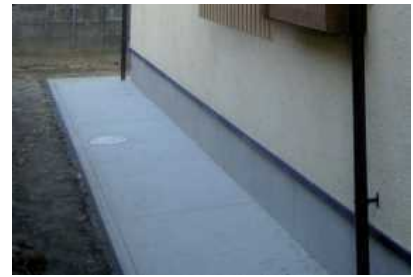
基礎周囲の犬走り
