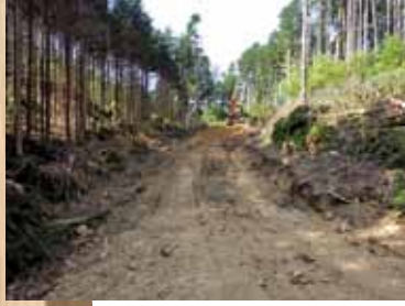
写真7 国有林の林業専用道の新設工事箇所
