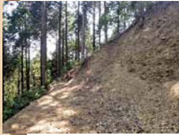
写真6 国有林作業道側から連結前の写真（民有林側で作業道を延長し、連結）
