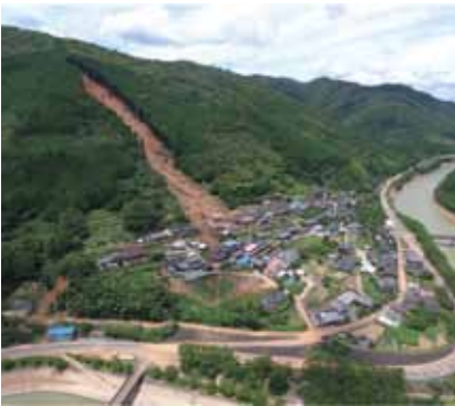
平成30年7月豪雨により人家に被害が発生 (愛媛県西予市)
