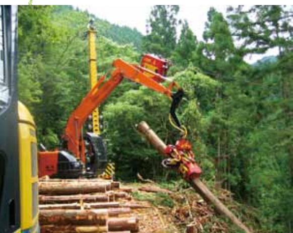
タワーヤードによる集材
