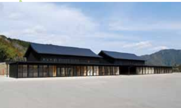
那賀町林業ビジネスセンター
