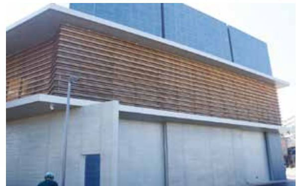
外装にルーバーを使用した例
