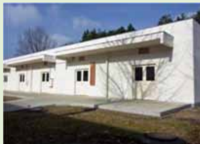
セルロースナノファイバー製造技術実証施設
