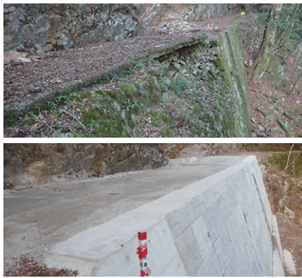
林道の改良工事(上:実施前 下:実施後)
