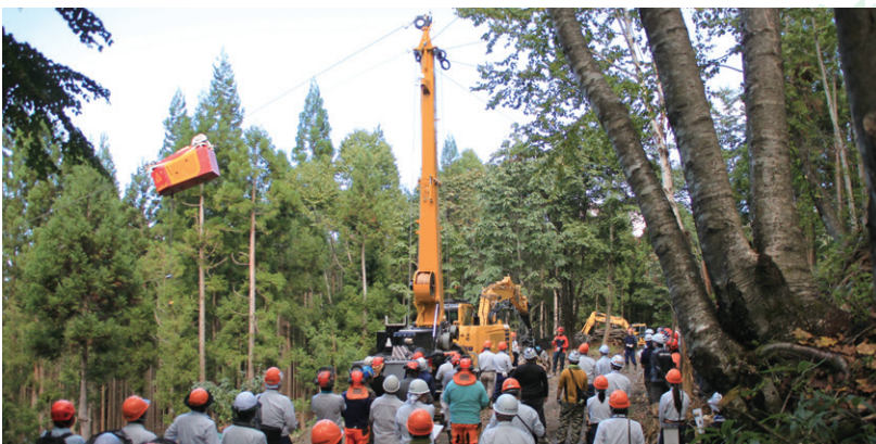
簡易架線作業システムの現地検討会
