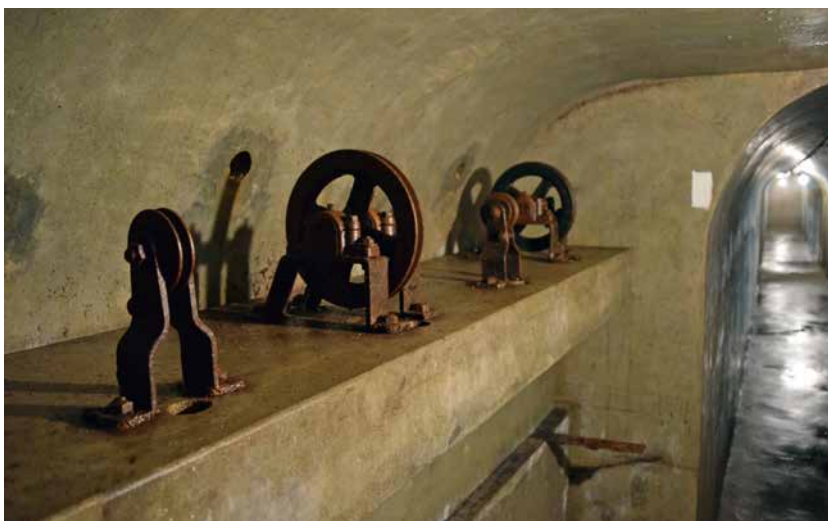
地下道に残る滑車
